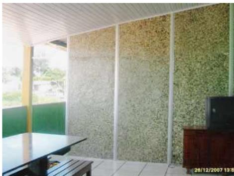
Fig. 64: Pannel de divisória de chapa ecológica Tetra Pak. (Fonte: site Ecopex).
