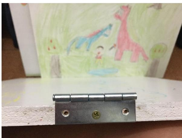
**Figura 27:** Processo de colocação das dobradiças (2019)
