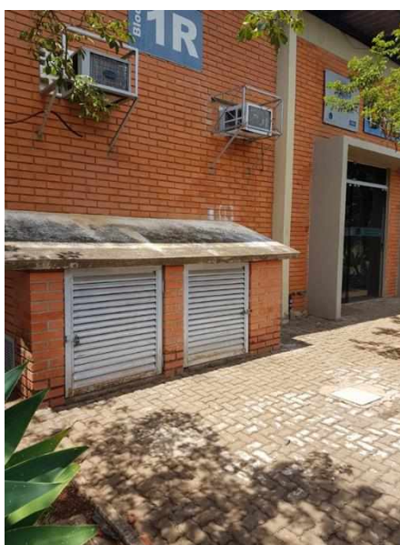
Figura 25 – Passeio sem espaço de passagem suficiente – Bloco 1R
