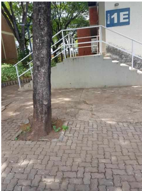
Figura 22 – Calçada irregular em frente ao Bloco 1E
