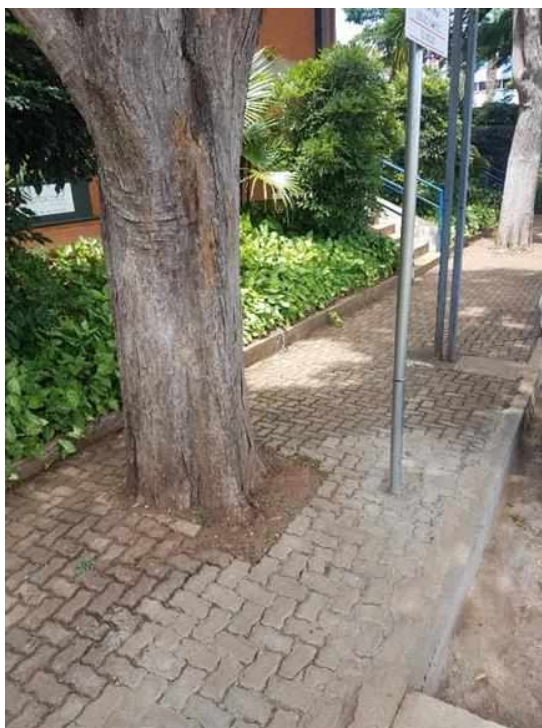
Figura 16 – Passeio mal dimensionado, com obstáculos - Bloco 1K
