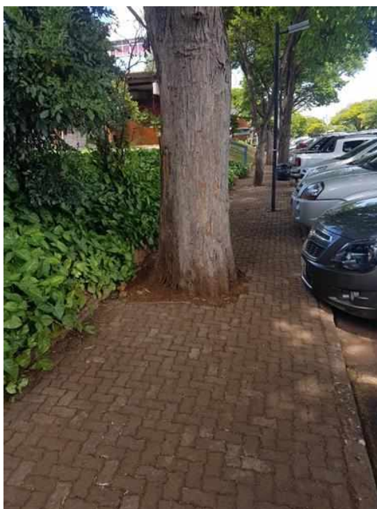
Figura 17– Passeio mal dimensionado, com obstáculos - Bloco 1K
