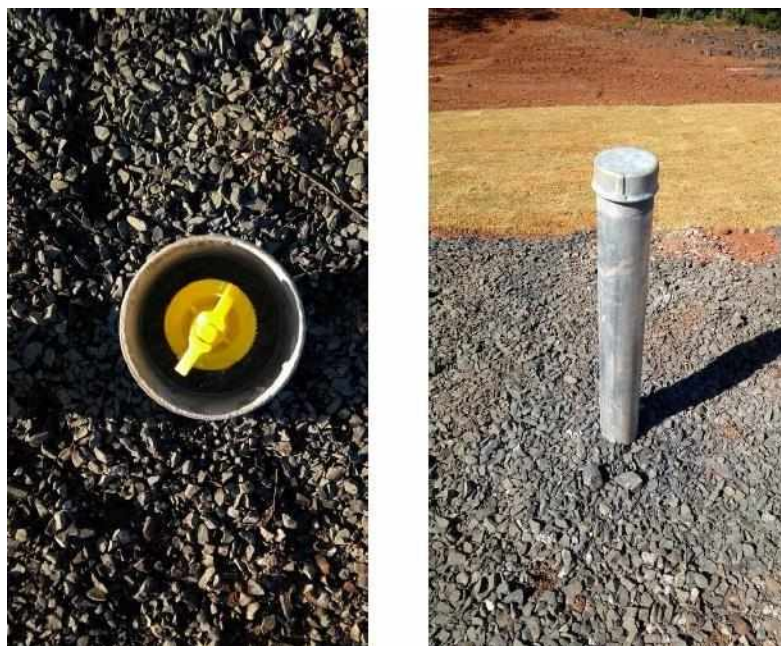
Figura 18: Instalação do piezômetro finalizada.
