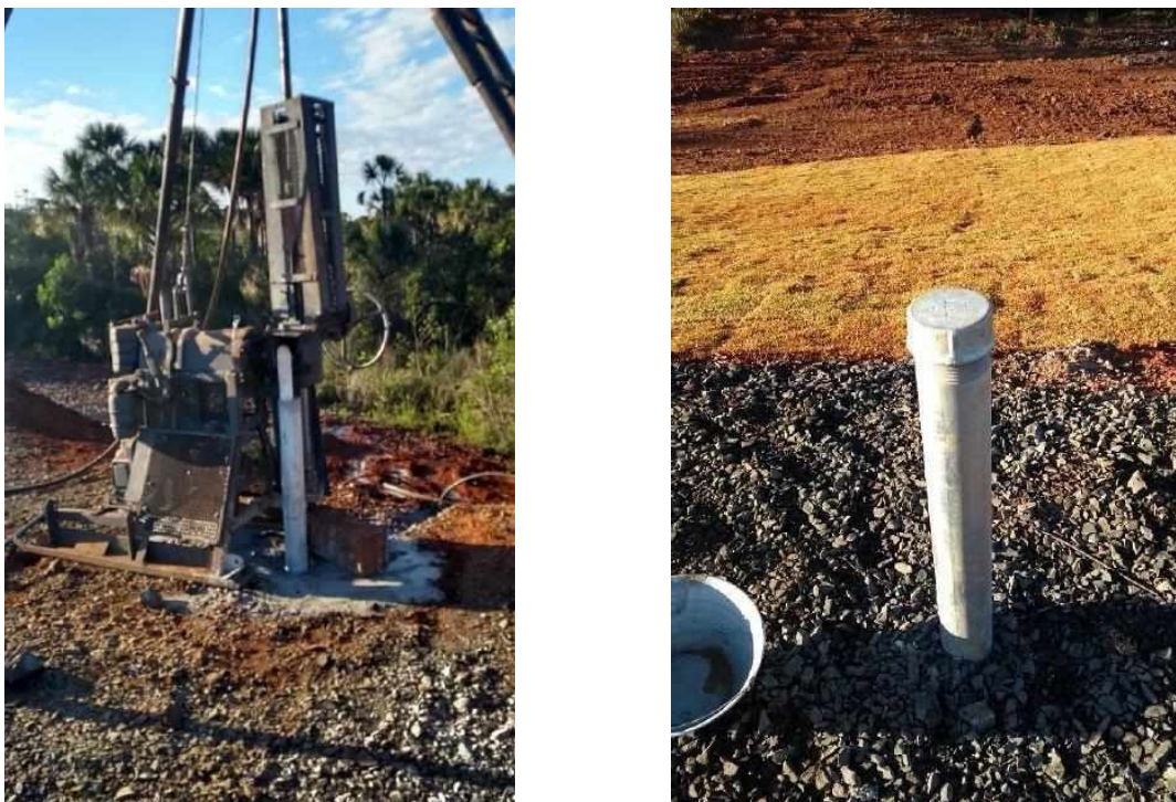
Figura 16: (a) Descida do tubo; (b) Instalação finalizada.
