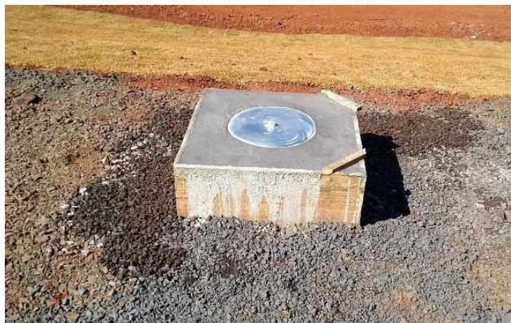
Figura 20: Marco superficial instalado.
