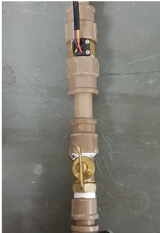
Figura 13– Instalação de válvula globo e medidor de fluxo
