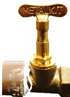
Figura 12– – Válvula globo
