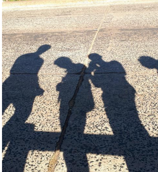
Figura 41 - Junta de dilatação na faixa de rolamento de concreto
