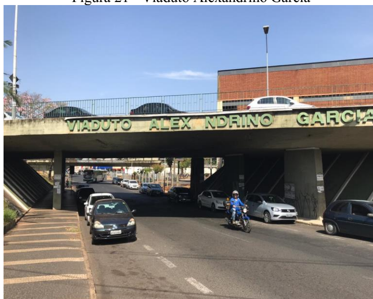
Figura 21 - Viaduto Alexandrino Garcia
