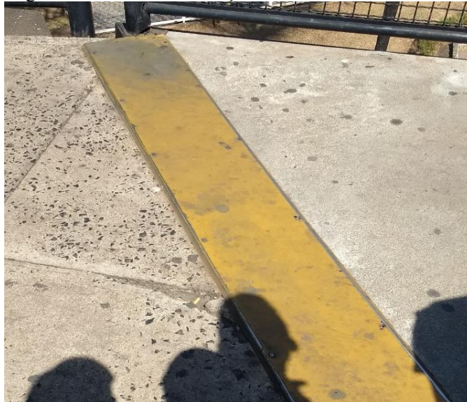
Figura 20 – Junta de dilatação com cobrimento metálico
