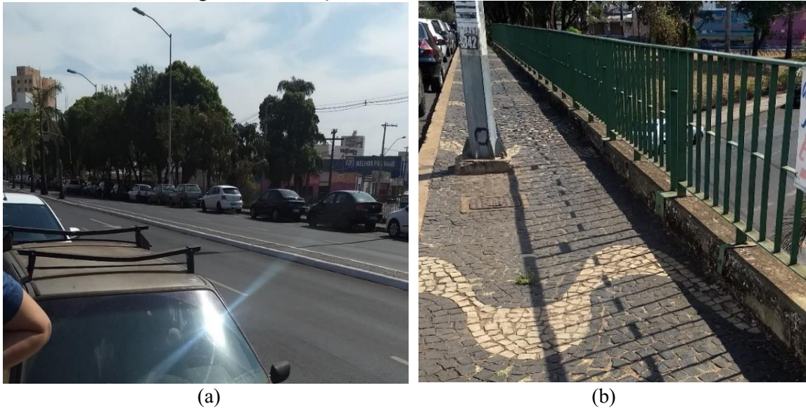
Figura 22- Condição das faixas de rolamento e passeio
