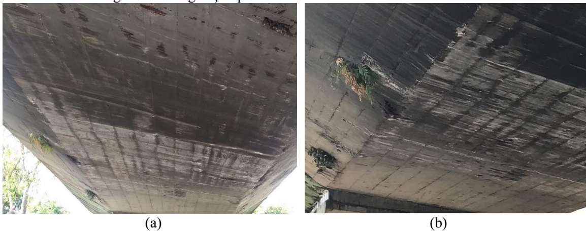
Figura 17 - Vegetação parasitária e mossas de colisão de veículos
