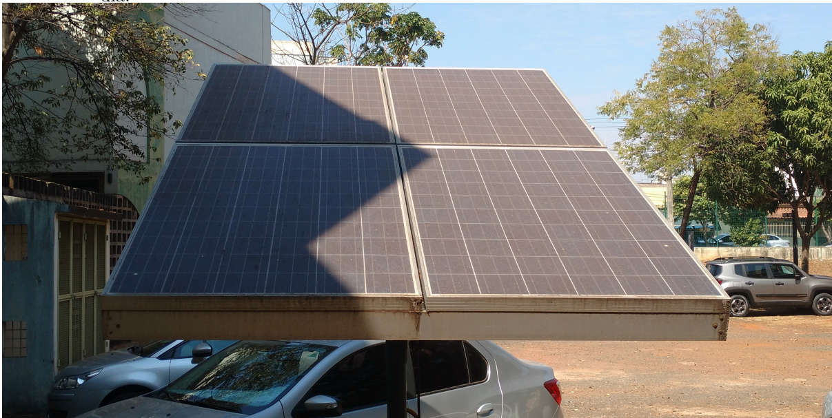
Figura 20 – Módulo fotovoltaico parcialmente sombreado por prédio na Universidade Federal de Uberlândia.
