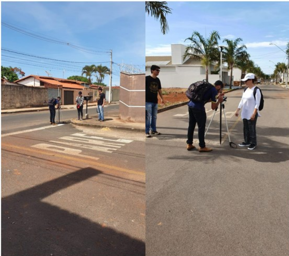
Figura 06 – Levantamento dos pontos de controle
