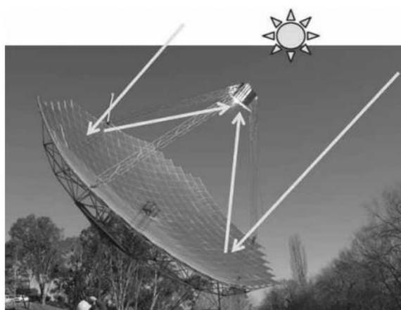
Figura 2.4 - Coletor de prato parabólico (SCHIEL; KECK, 2012).
