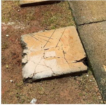
Foto 41: Caixa de passagem inadequada
