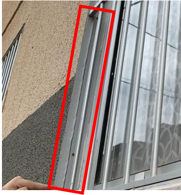
Foto 29: Recuo insuficiente
