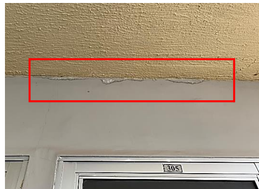
Foto 6: Infiltrações na laje
