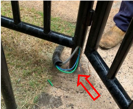
Foto 45: Deterioração do isolamento dos condutores
