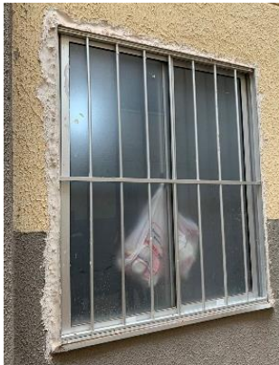
Foto 33: Ausência de vidro para vedação
