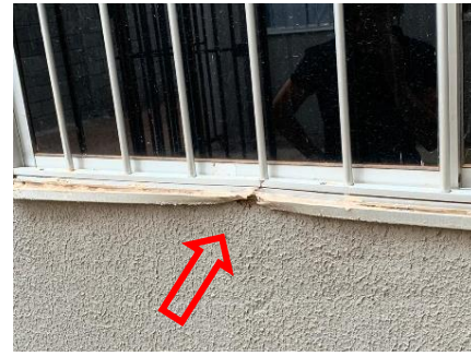
Foto 32: Vedação inadequada
