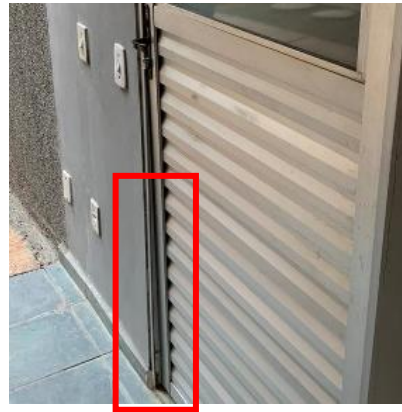
Foto 33: Ausência de vidro para vedação
