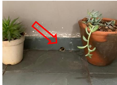
Foto 37: Drenagem com vazão insuficiente
