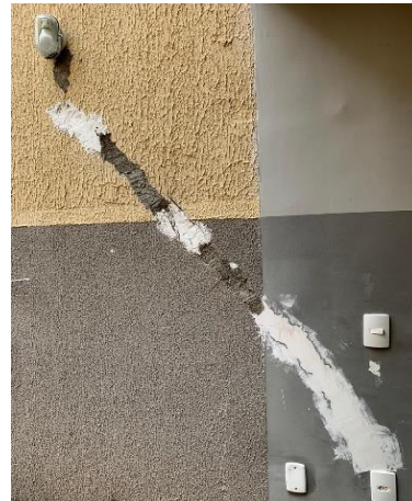
Foto 6: Infiltrações na laje
