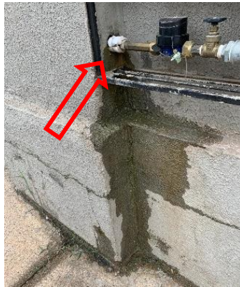
Foto 38: Drenagem com vazão insuficiente
