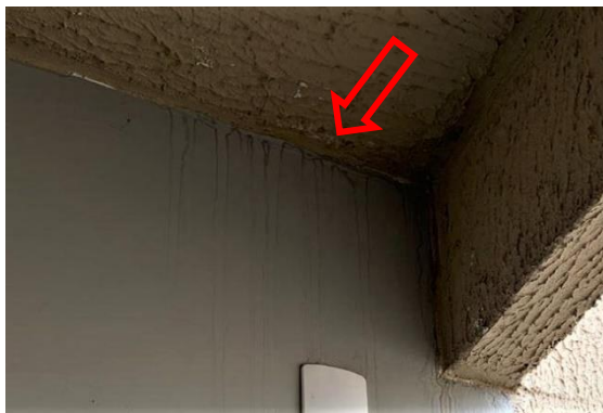
Foto 5: Infiltrações na laje
