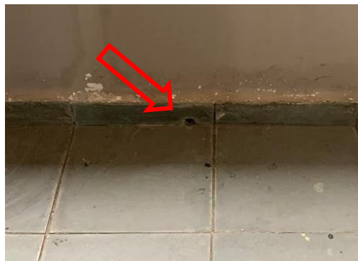
Foto 38: Drenagem com vazão insuficiente
