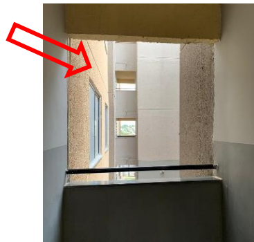
Foto 33: Ausência de vidro para vedação
