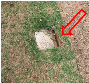
Foto 43: Cabos elétricos expostos
