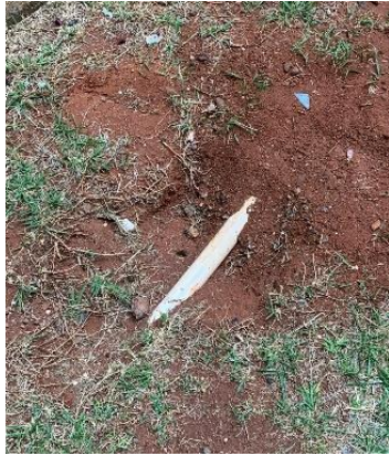
Foto 36: Vazamento nas tubulações do hidrômetro
