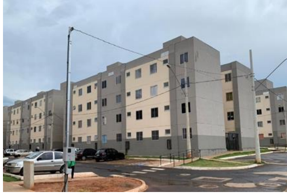
Foto 1: Blocos do Lote 4
