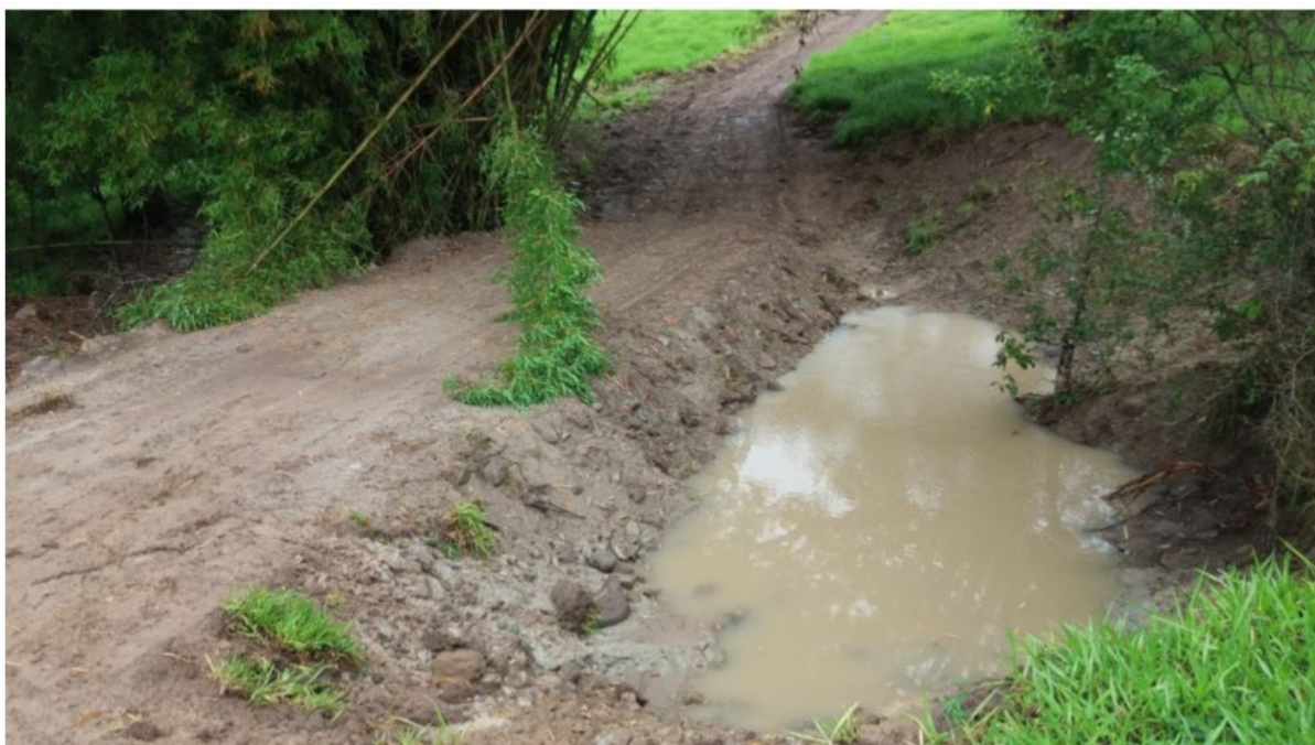
Figura 15C - Bacia de infiltração
