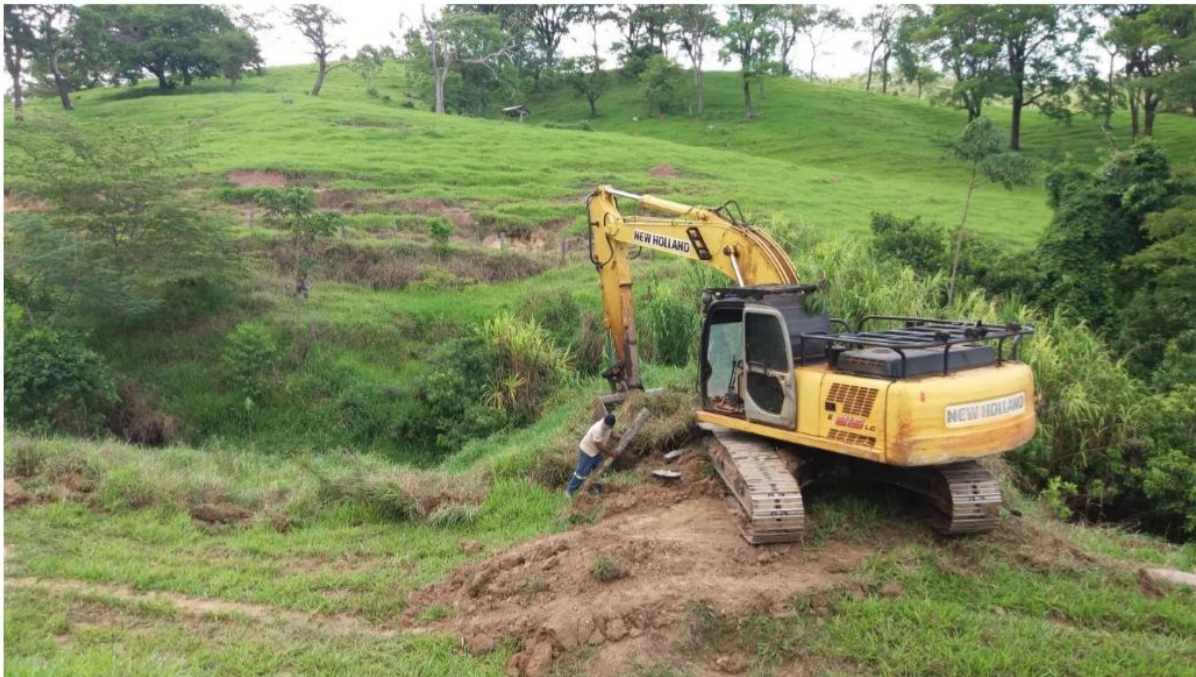
Figura 16: Início da construção da Represa do primeiro afluente do córrego principal.
