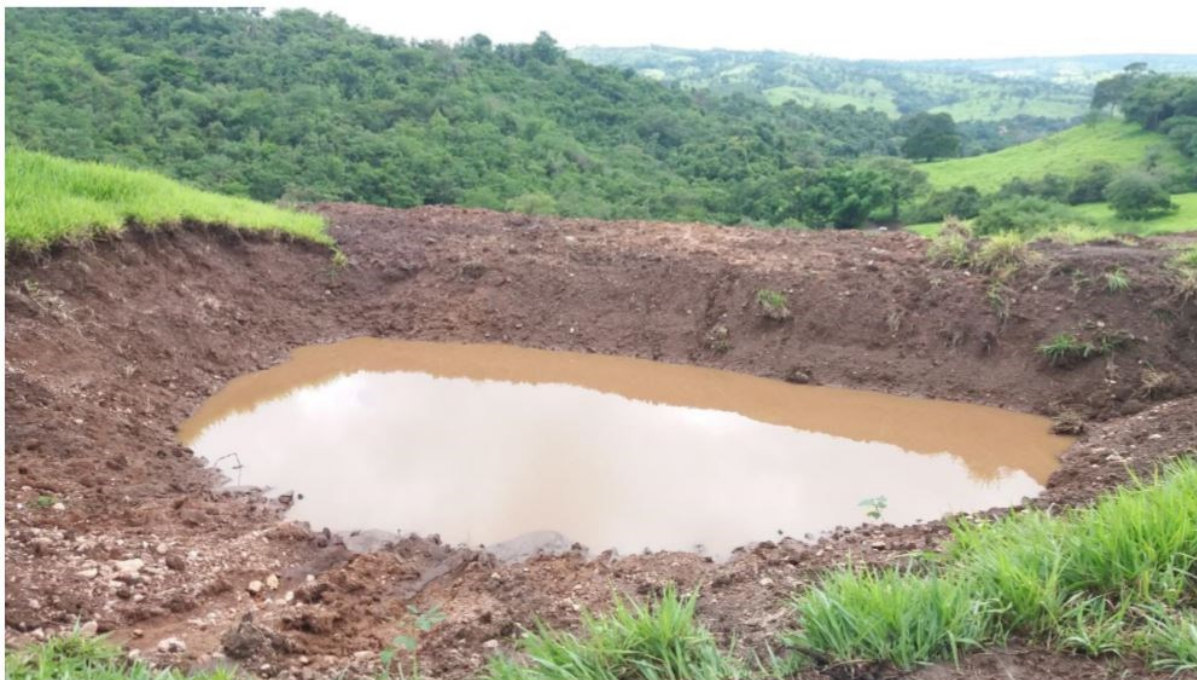
Figura 15D - Bacia de infiltração
