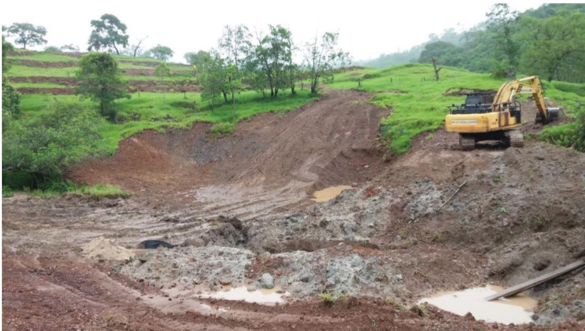
Figura 18: Início da construção da Represa do segundo afluente do córrego principal.
