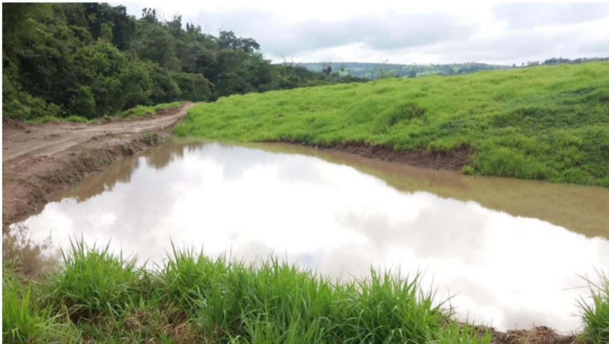
Figura 15B - Bacia de infiltração
