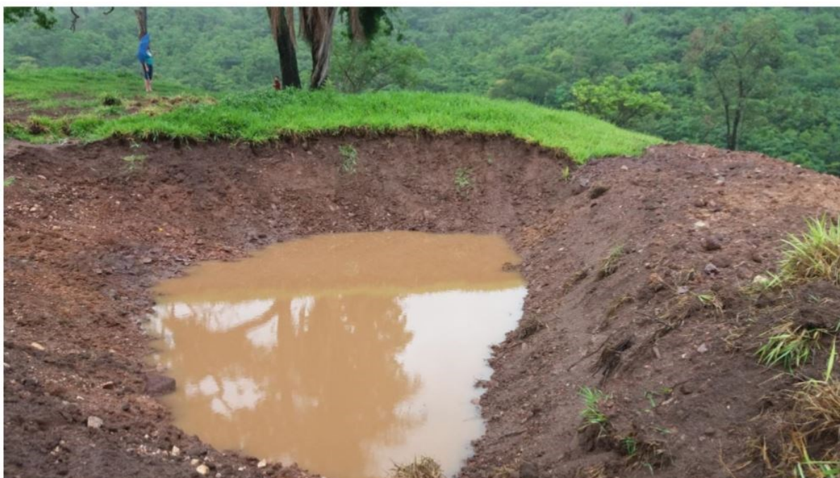
Figura 15A - Bacia de infiltração
