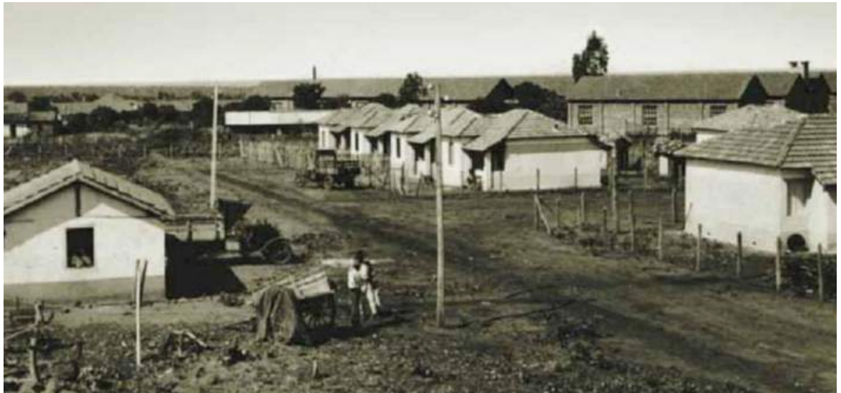
► FIGURA 5: Foto da Vila Operária, atual bairro Nossa Sra. Aparecida (Fonte: Revista Almanaque de Uberlândia, ed.5.
