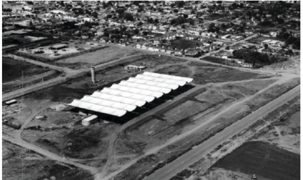
► FIGURA 8: Construção do Terminal Rodoviário Presidente Castelo Branco (Fonte: Revista Almanaque de Uberlândia)
