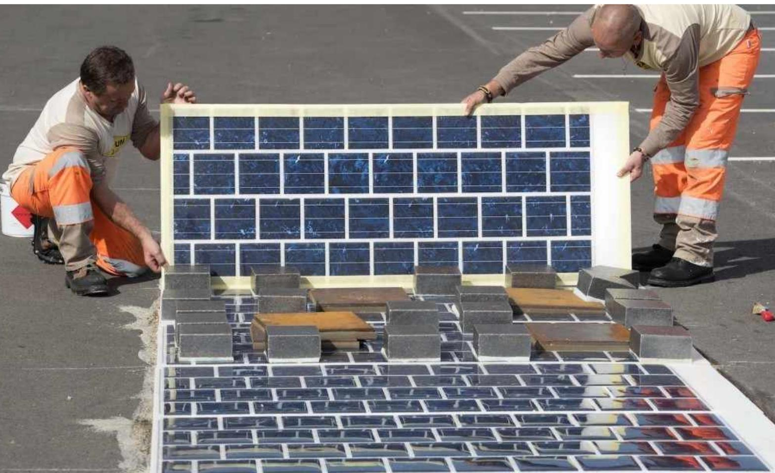
Figura 109: Painéis solares Colas Wattway sendo aderidos a uma rodovia, com pesos metálicos aplicados à superfície para melhorar o processo de colagem.
