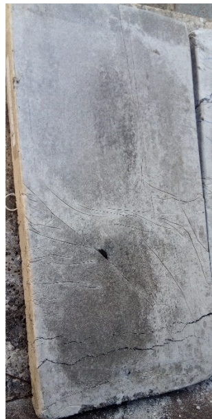
Figura 77 - Panorama de Fissuração.
