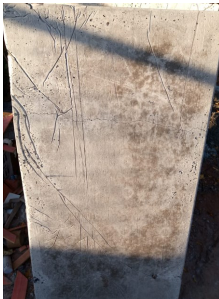
Figura 61 - Panorama de Fissuração.
