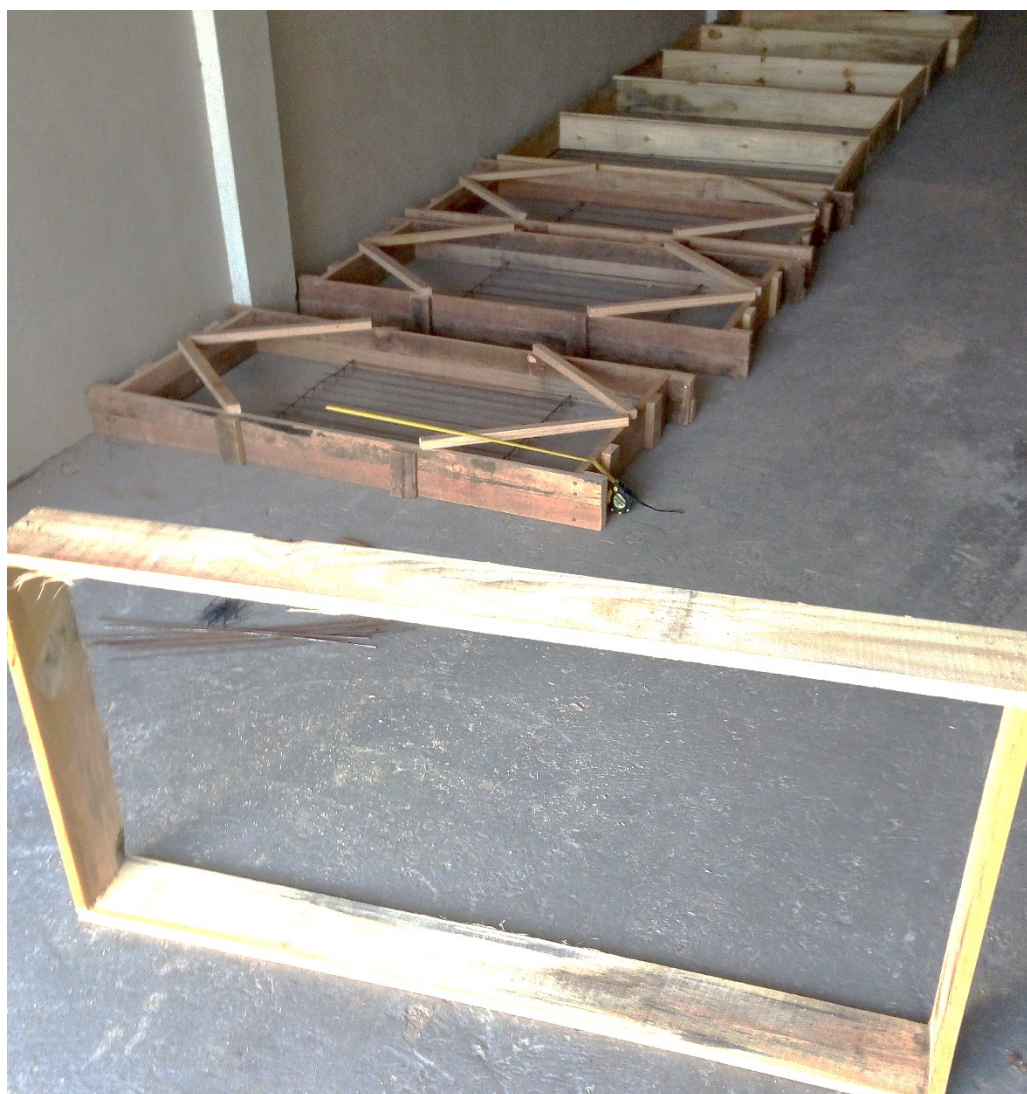
Figura 30 - Execução das fôrmas.
