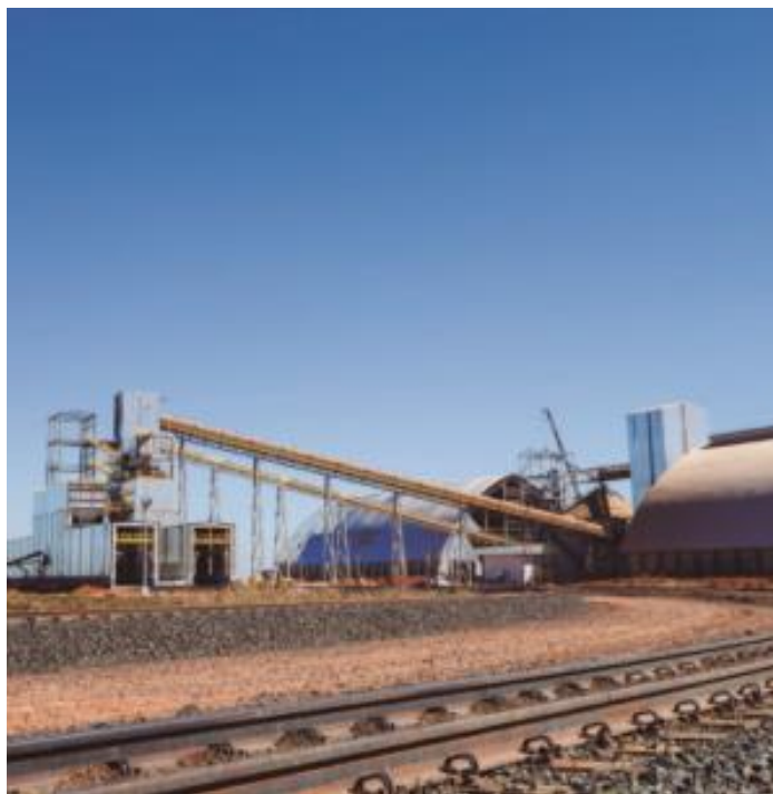
Figura 39 – Terminal Integrador de Uberaba, 2017.
