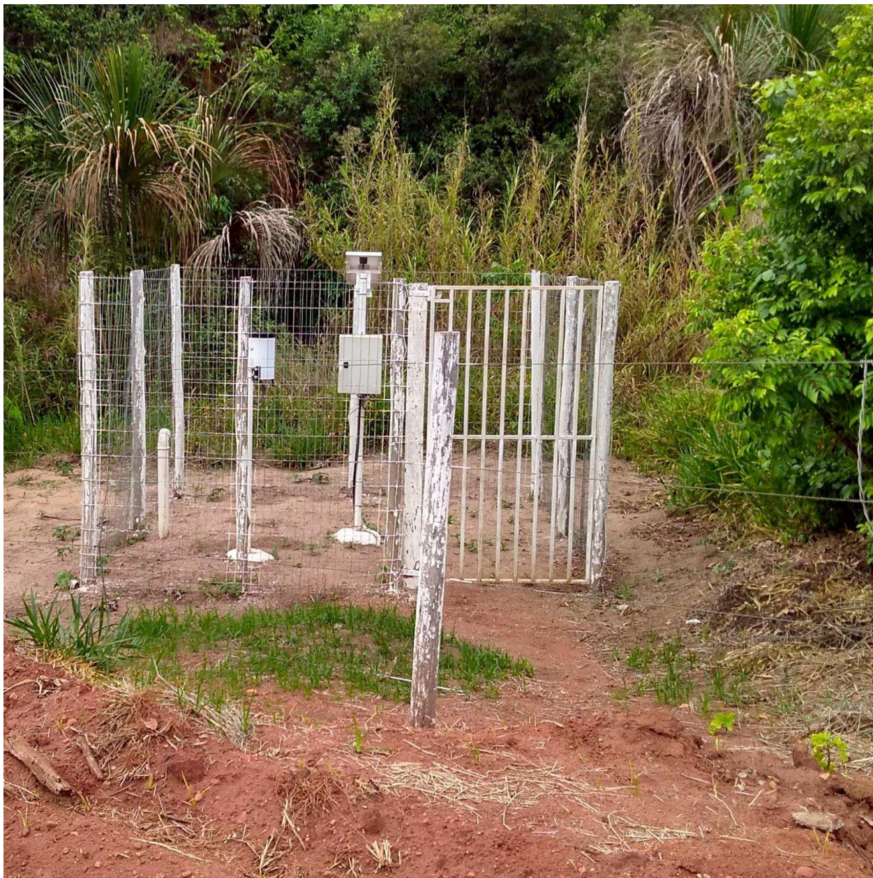
FIGURA 6: Estação hidrométrica instalada na Bacia Hidrográfica Experimental do Córrego Água Vermelha
