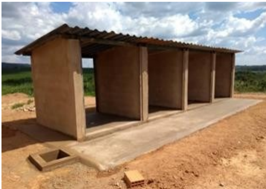
FIGURA 15 – Área de compostagem dos suínos mortos da Propriedade A.
