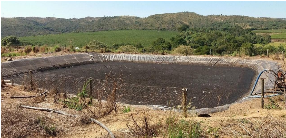
FIGURA 19 – Lagoa de estabilização da Propriedade A.
