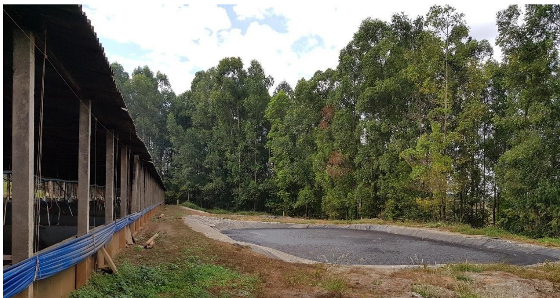
FIGURA 25 – Lagoa de estabilização 1 da Propriedade B.
