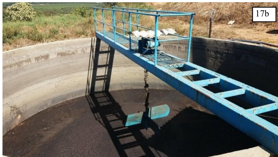
17a – Conjunto tanque de equalização e agitador mecânico. 17b – Agitador mecânico. Fonte: do autor, 2019.
