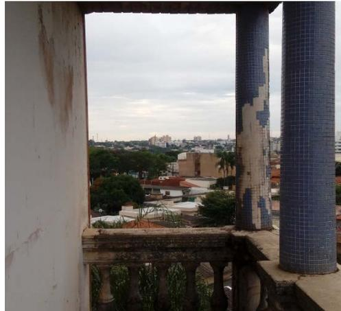
Figura 64: detalhe do desenho da guarda corpo e deterioração do revestimento dos pilares com pastilhas hidráulicas
