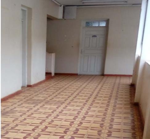
Figura 49: piso tipo do pavimento de ladrilho hidráulico.
