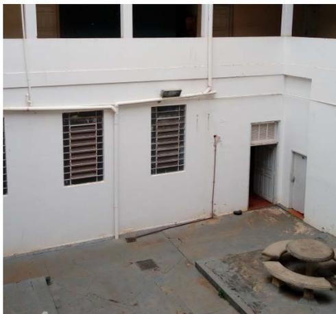
Figura 53: tubulação aparente no pátio central
