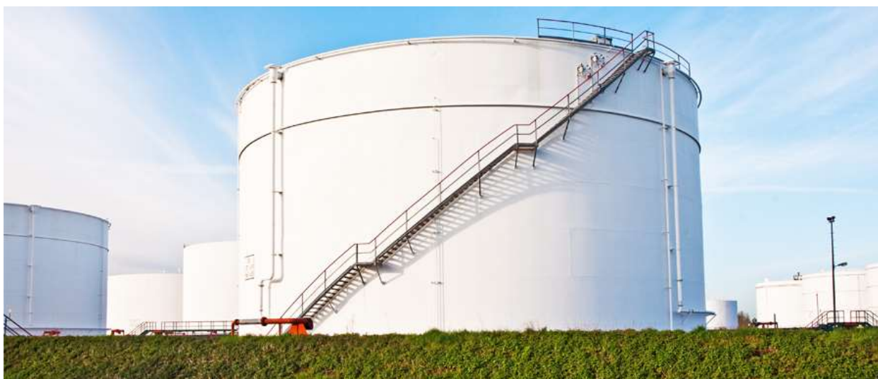
Figura 25 - Escadas de acesso a um tanque de armazenamento de combustível.
