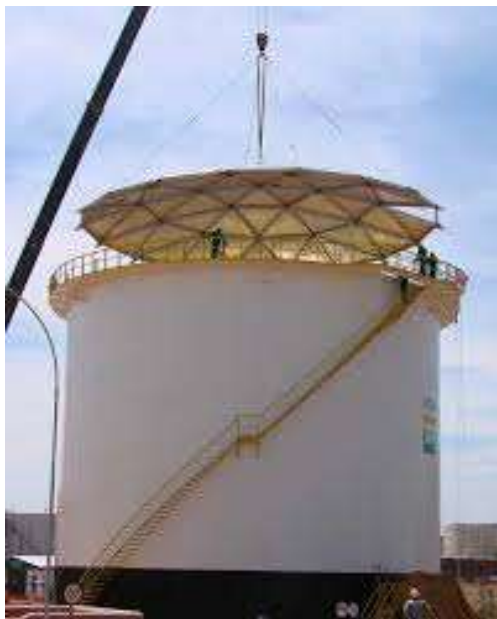
Figura 26 - Remoção do teto de um tanque de armazenamento de combustível.
