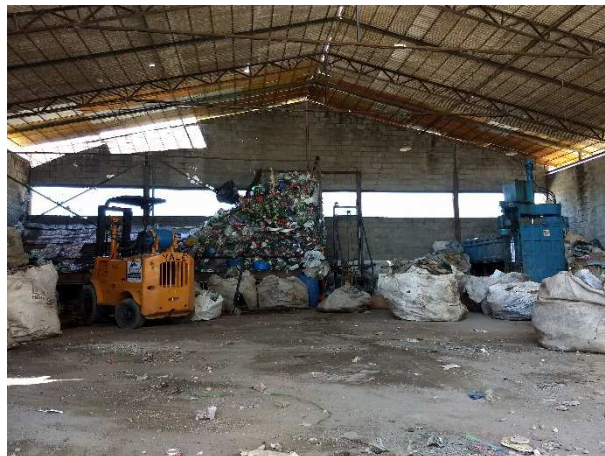
(b) Vista interna do galpão
