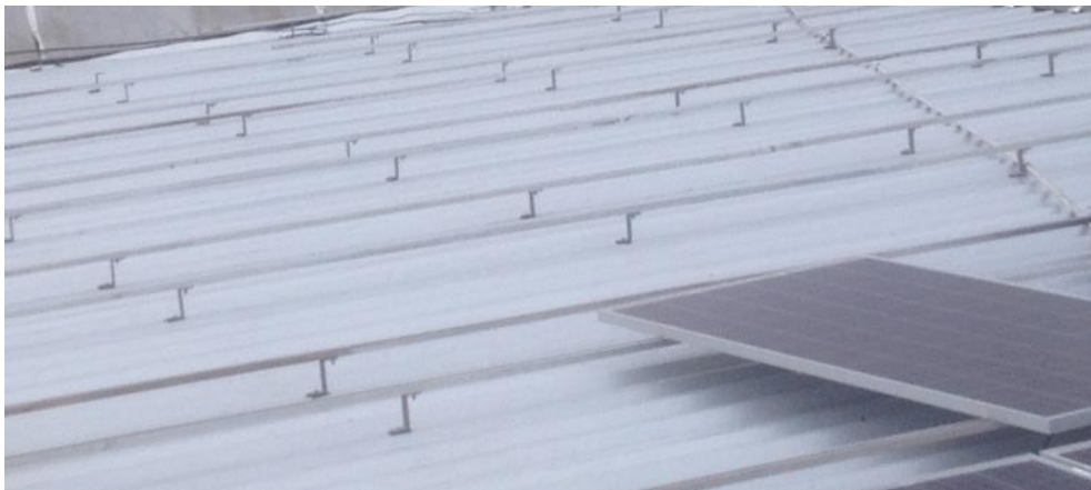
Figura 18 - Estrutura metálica integrativa.
