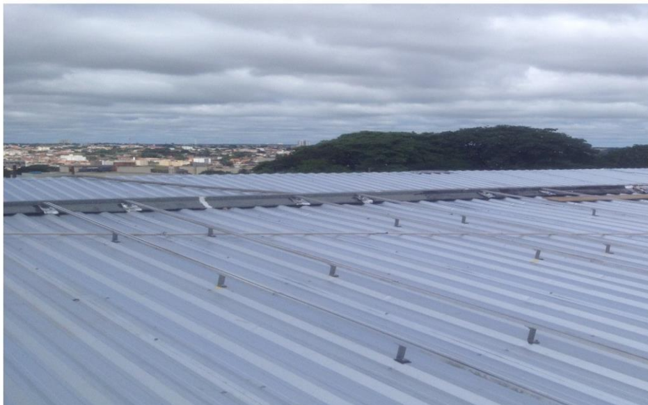
Figura 12 - Telhado novo do Supermercado Lunasa.
