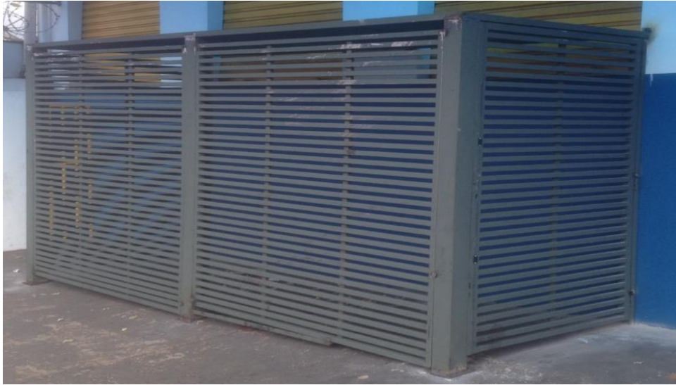
Figura 15 - Local onde será abrigado o inversor e o transformador.
