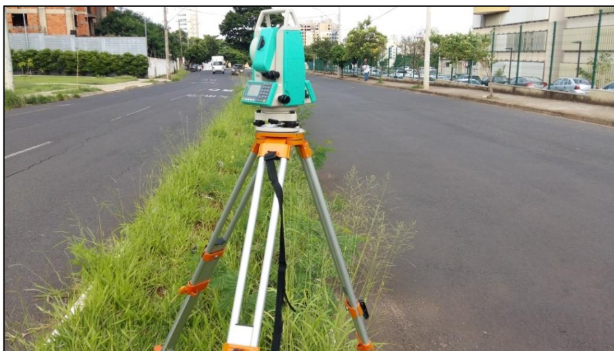
Figura 35 – Estação total utilizada no levantamento
