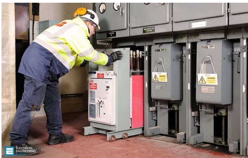
Figura 5-7 Disjuntor de média tensão extraível ABB.
