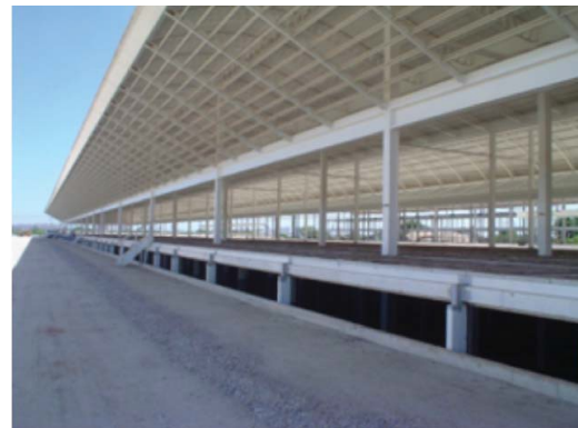
Figura 39: Vista do piso técnico. O nível do hospital está 80 cm sobre o nível de acesso. Fonte: Base de dados CTRS (PÉREN,2006).
