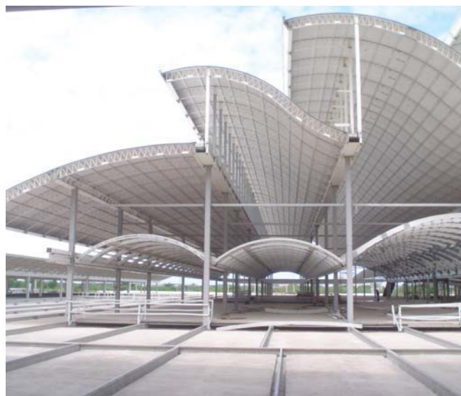
Figura 49: Vista dos arcos móveis sob a cobertura. Fonte: PÉREN,2006.
