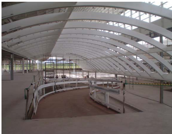
Figura 48: Vista da rampa desde o segundo nível, sob a cobertura em arco móvel. Fonte: PÉREN,2006.
