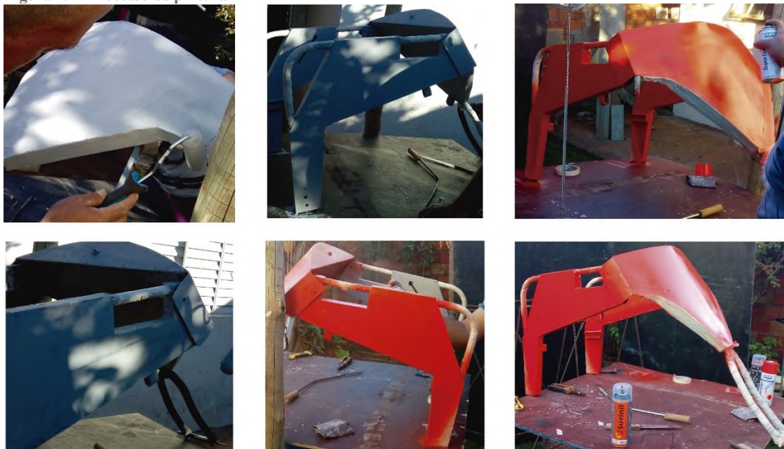
Figura 49 - Processo de pintura
