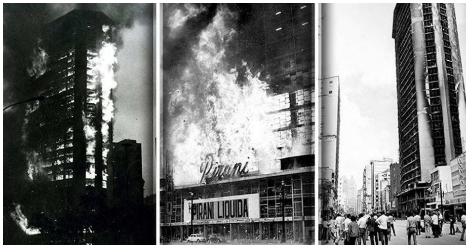
Imagem 2 Sobrecarga na rede elétrica provoca incêndio no Edifício Andraus. Fonte: (BOL/FOLHAPRESS, 2017)
