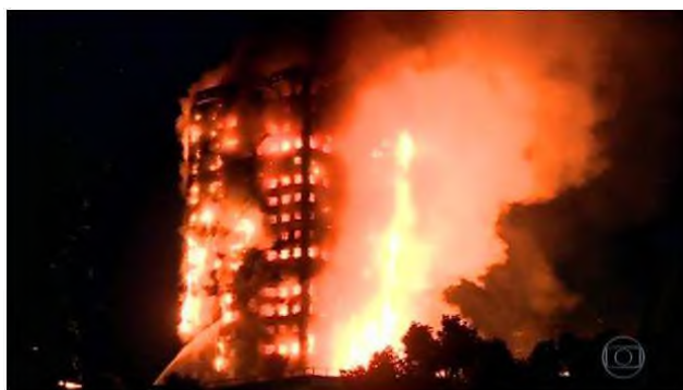
Figura 12 Incêndio em prédio Residencial em Londres Fonte: https://www.youtube.com/watch?v=n5XX4J7DXL8
