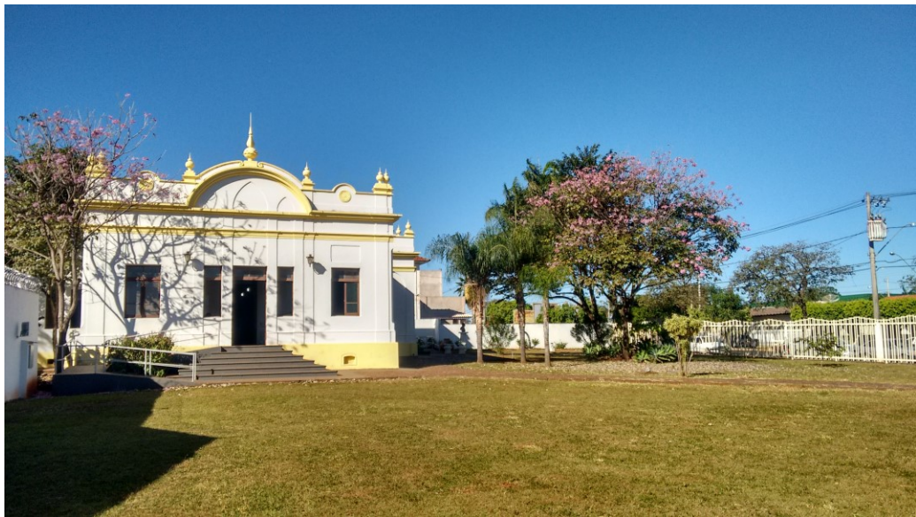
Figura 1 – Terreno e edificação do atual Museu Antropológico de Ituiutaba. Jul/2017. Acervo pessoal.
