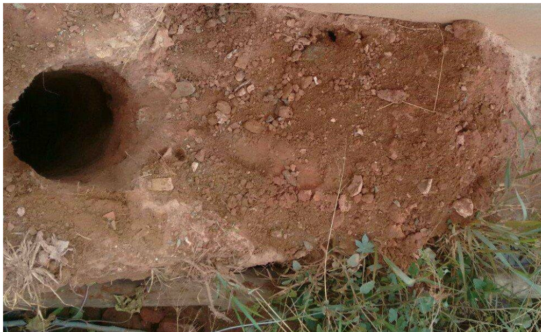
Figura 12: Perfuração para instalação de padrão elétrico no bairro Tubalina Uberlândia/MG, 2017.
