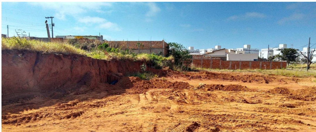
Figura 09: Área de escavações no bairro Shopping Park- Uberlândia/MG, 2016.
