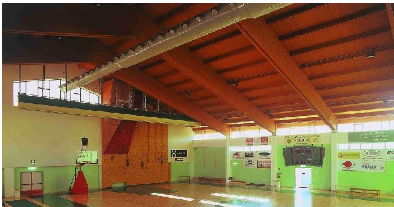
Figura 3 – Viga de MLC
