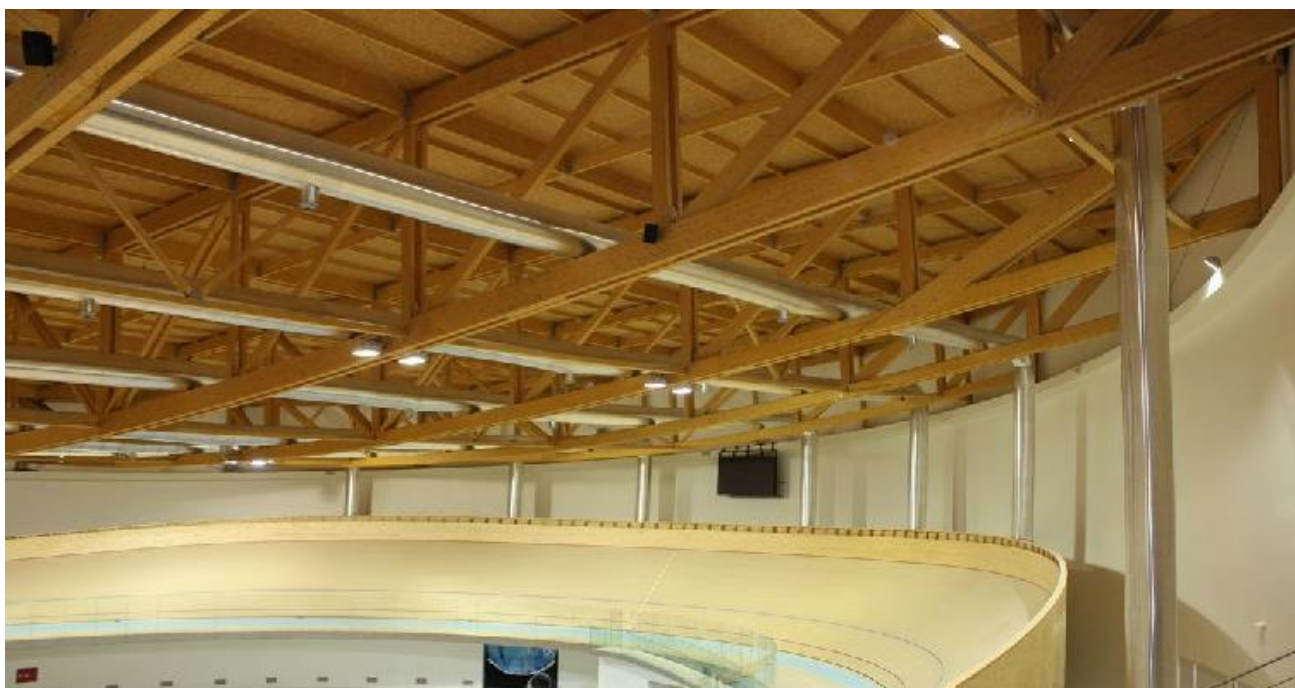
Figura 2 – Estrutura de treliça de MLC
