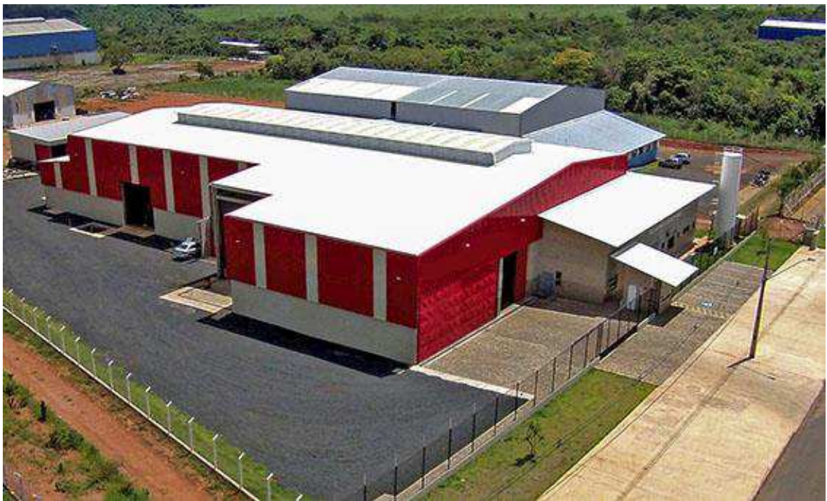
Figura 3.1 – Vista aérea da empresa (fonte: própria empresa).
