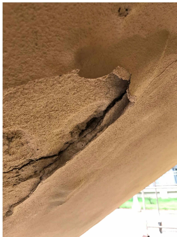
Figura 57- Infiltrações na parte inferior da escada
