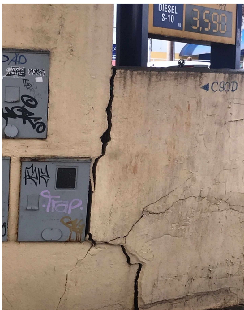
Figura 73- Vistas do muro de arrimo Mercado Municipal
