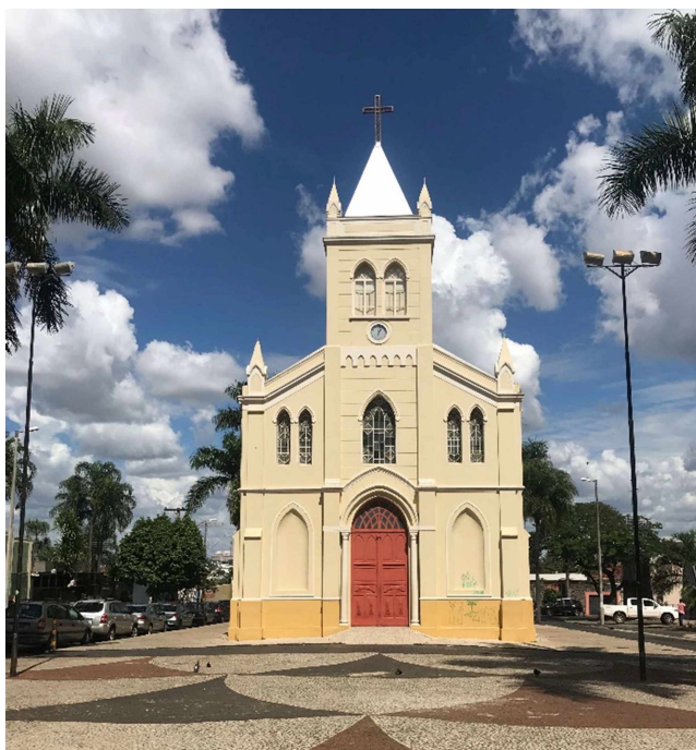
Figura 61 - Estado atual da fachada da Igreja Nossa Senhora do Rosário
