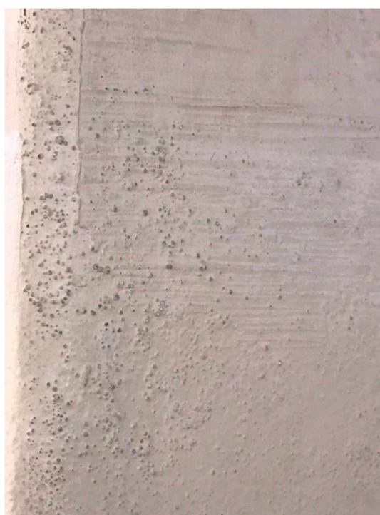
Figura 84 - Exemplo de vesículas em pano cego do Mercado Municipal
