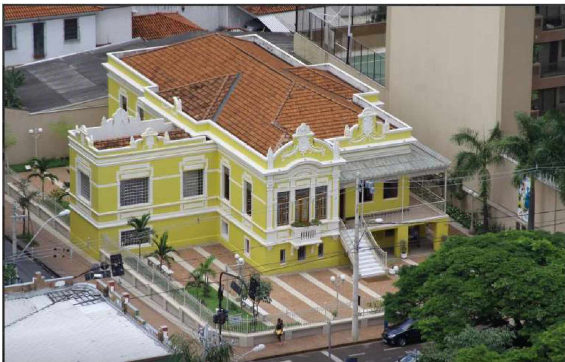
Figura 51 - Vista aérea da edificação
