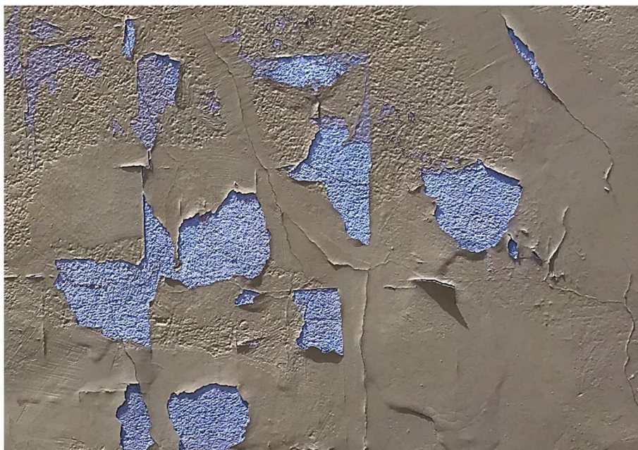
Figura 91 - Exemplo de pintura acrílica impermeável em fachada da Biblioteca JK
