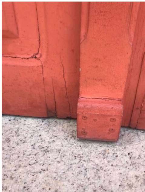
Figura 65- Patologias em portais e portas de madeira
