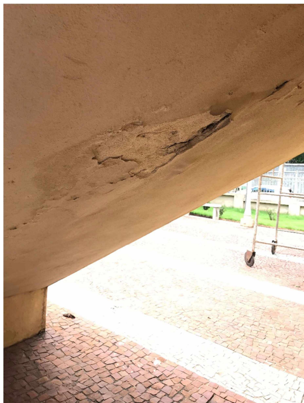
Figura 57- Infiltrações na parte inferior da escada
