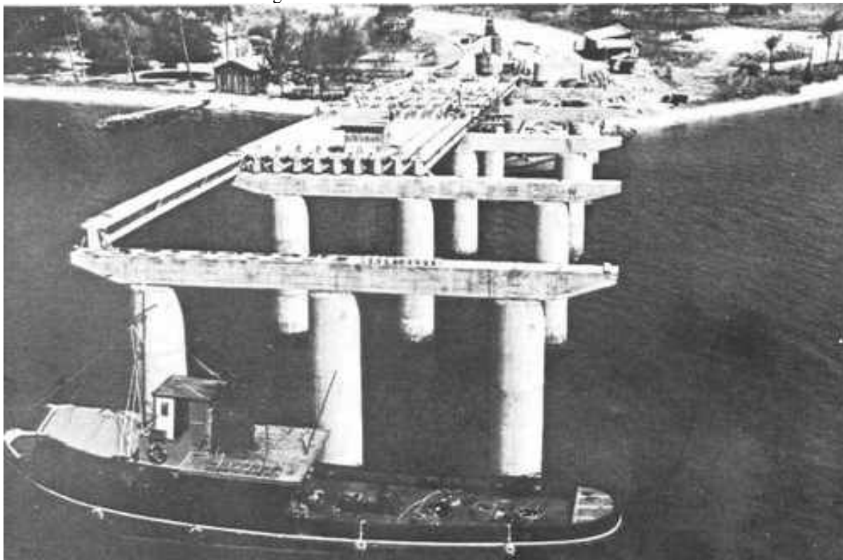
Figura 6 - Ponte do Galeão no Rio de Janeiro.
