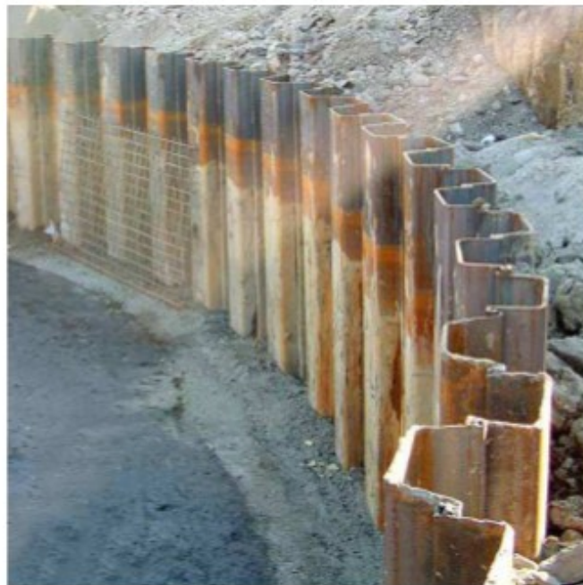
Figura 1 - Cortina estaca-prancha de aço (VARELA)
