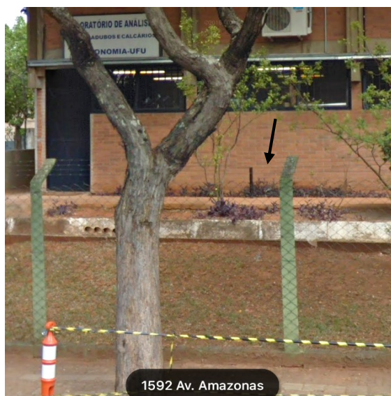
Figura 32- Bloco 4C ainda com canteiro da fachada externa.
