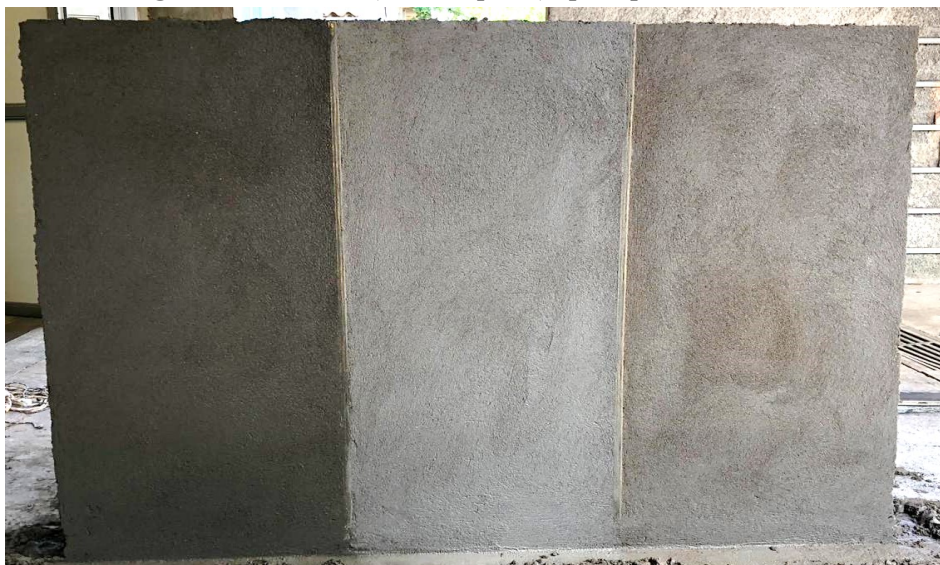
Figura 23 – Face A (com chapisco) após aplicação do reboco.
