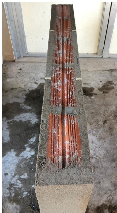
Figura 13 – Espessura do reboco aplicado no substrato.
