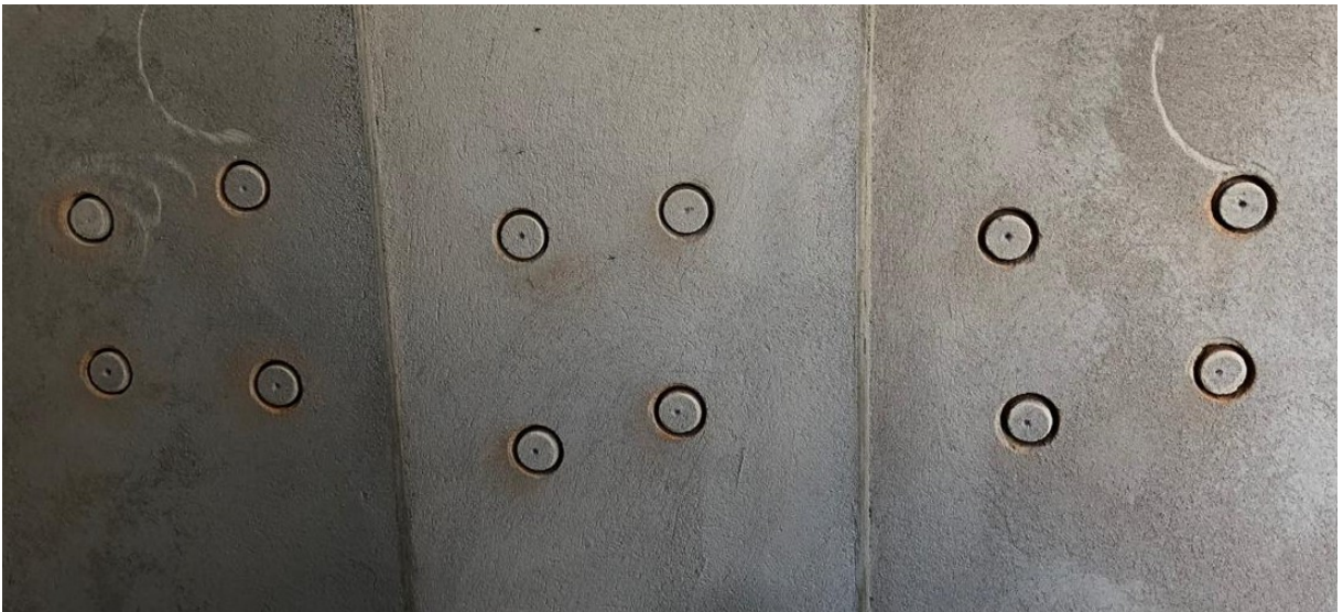
Figura 15 – Furos realizados pela serra copo.
