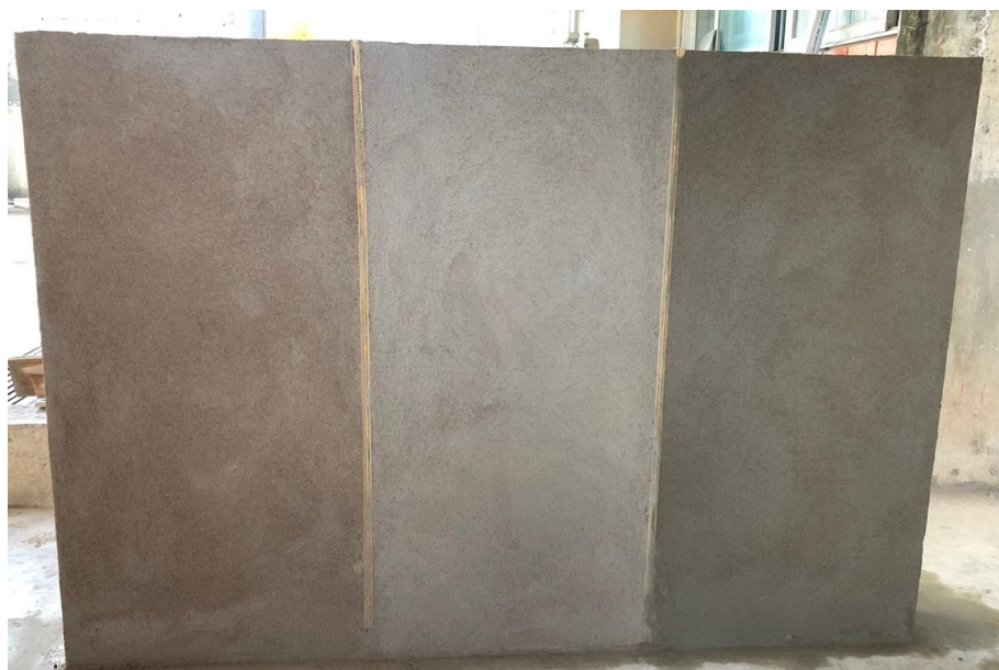
Figura 24 – Face B (sem chapisco) após aplicação do reboco.
