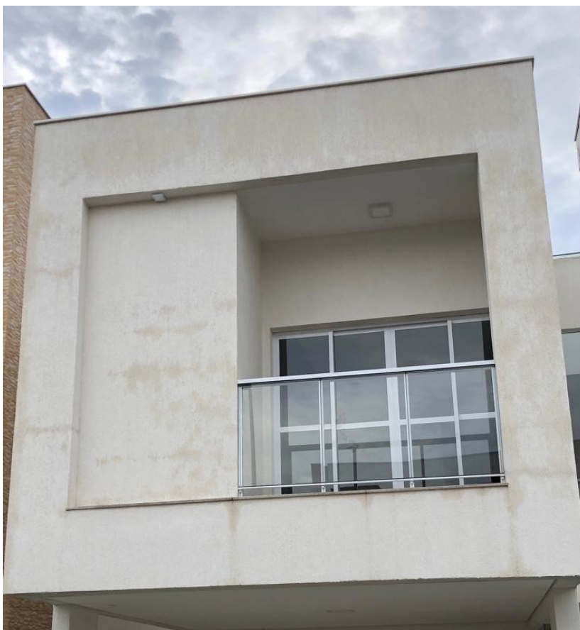
Figura 2 – Alto índice de absorção de água após períodos de chuva.
