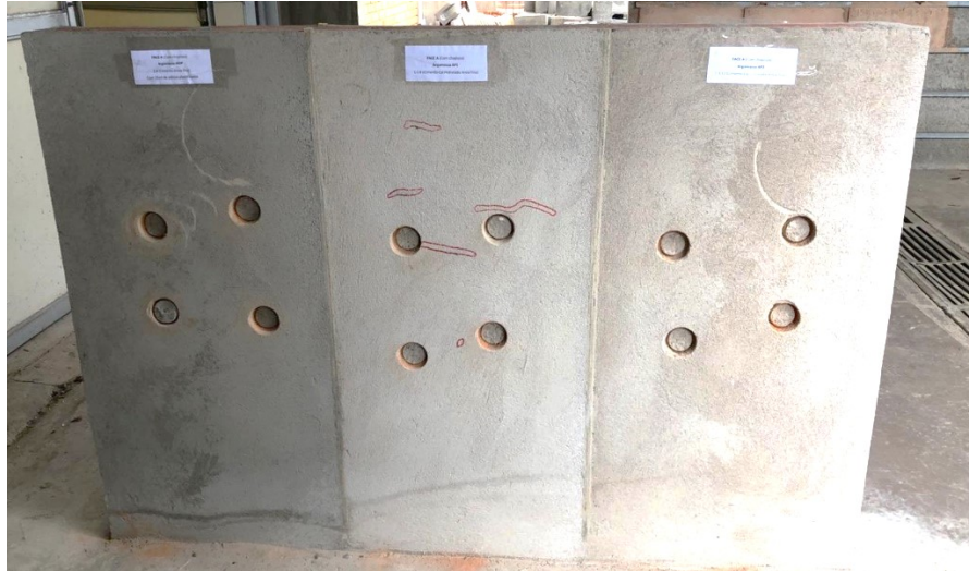
Figura 25 – Fissuras no painel de argamassa aos 28 dias.
