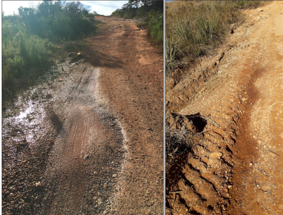
Figura 38 - Nascente GP6 antes e depois da manutenção da estrada.
