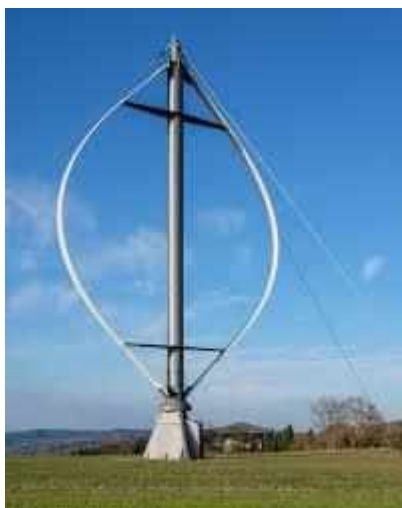
Figura 2-7 – Turbina Eólica de Eixo Vertical de Darrieus (WIKIPEDIA, 2014).
