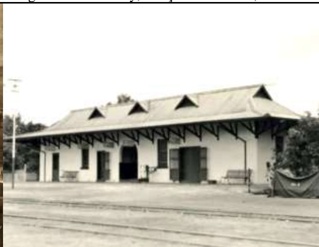
Figura 42: Vila Pery, estação ferroviária, 1930
