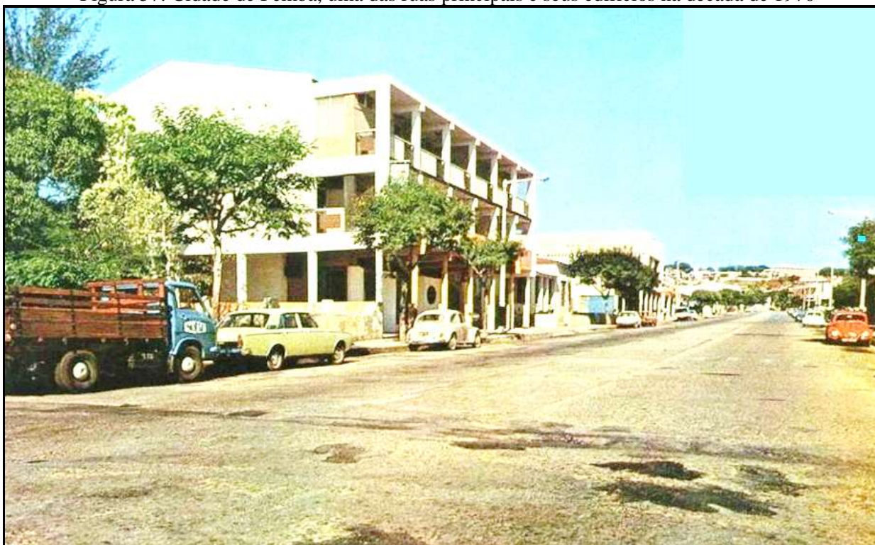
Figura 57: Cidade de Pemba, uma das ruas principais e seus edifícios na década de 1970
