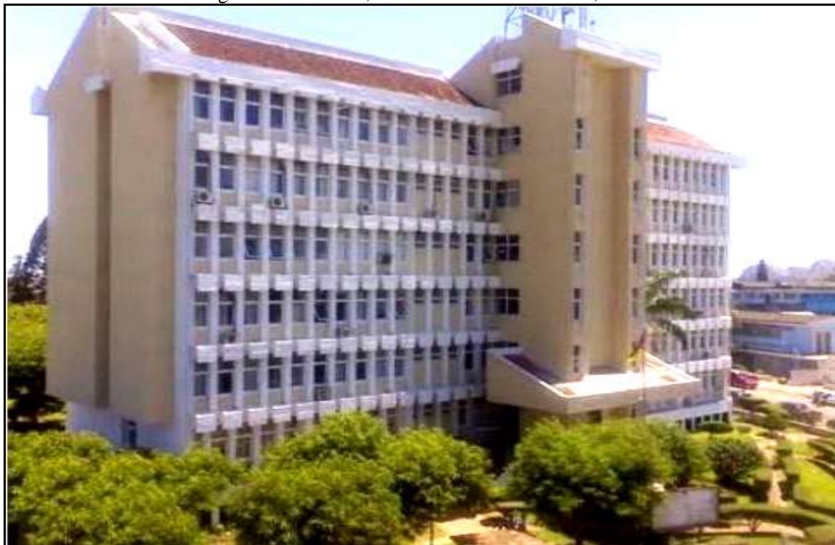
Figura 44: Chimoio, Edifício Sede do Governo, 2011
