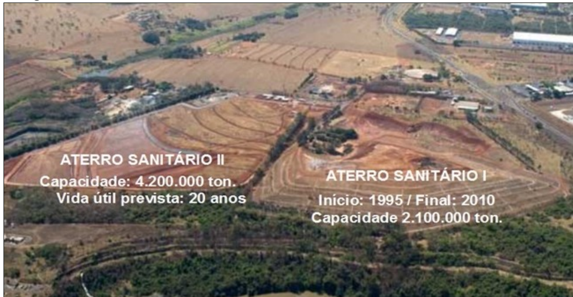
Figura 20 – Vista aérea do Aterro Sanitário – desativado I e em funcionamento II.
