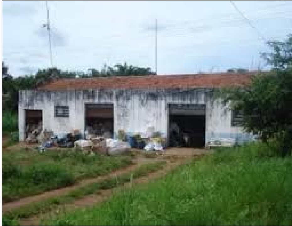
Figura 23 – Galpão no Bairro D. Zulmira, onde foram instalados ARCA E CORU, após o incêndio de 2009.
