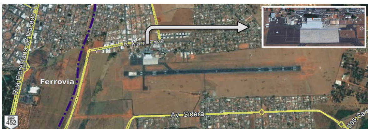
Figura 12. Área do aeroporto Tenente Coronel Aviador César Bombonato, Uberlândia. 2019.
