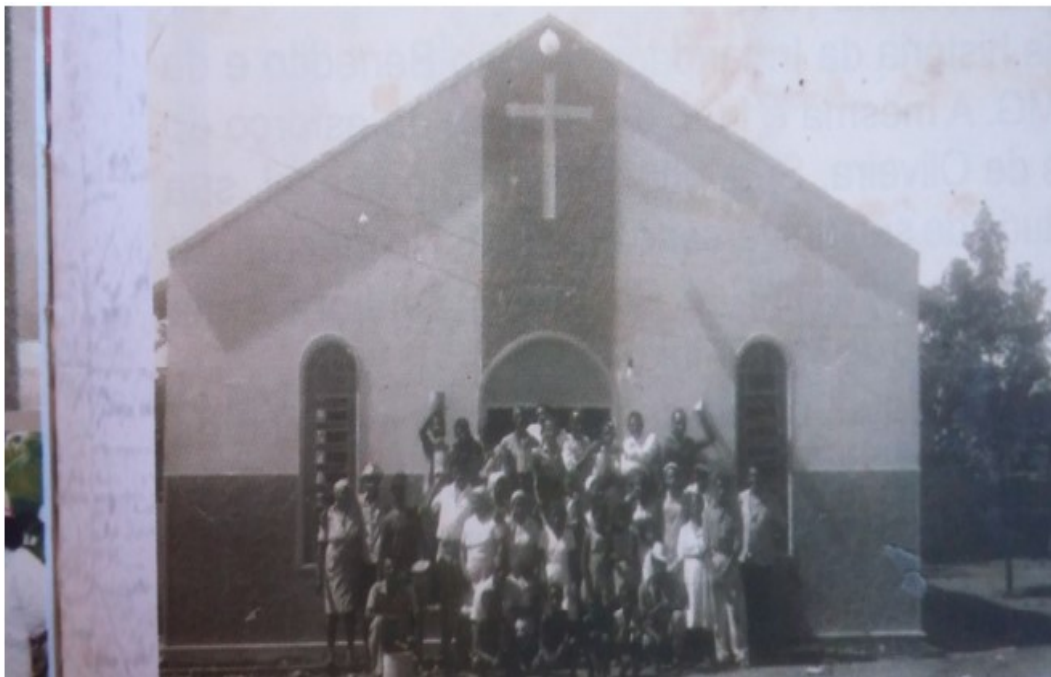
Figura 4: Imagem da Construção da capela de São Benedito-1971
