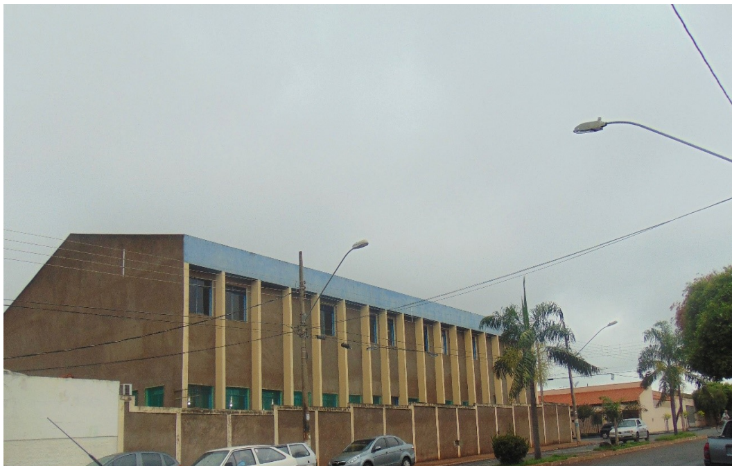
Figura 11: Imagem do Primeiro prédio o “Refeitório Municipal”, localizado na Escola Municipal Machado de Assis na cidade de Ituiutaba-MG.
