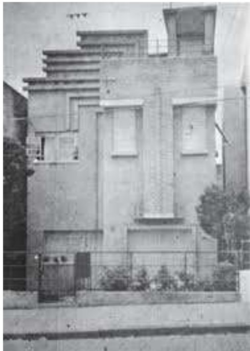
Figura 19 - Fachada de uma das dezessete casas que compõe o projeto da Alameda Lorena.
