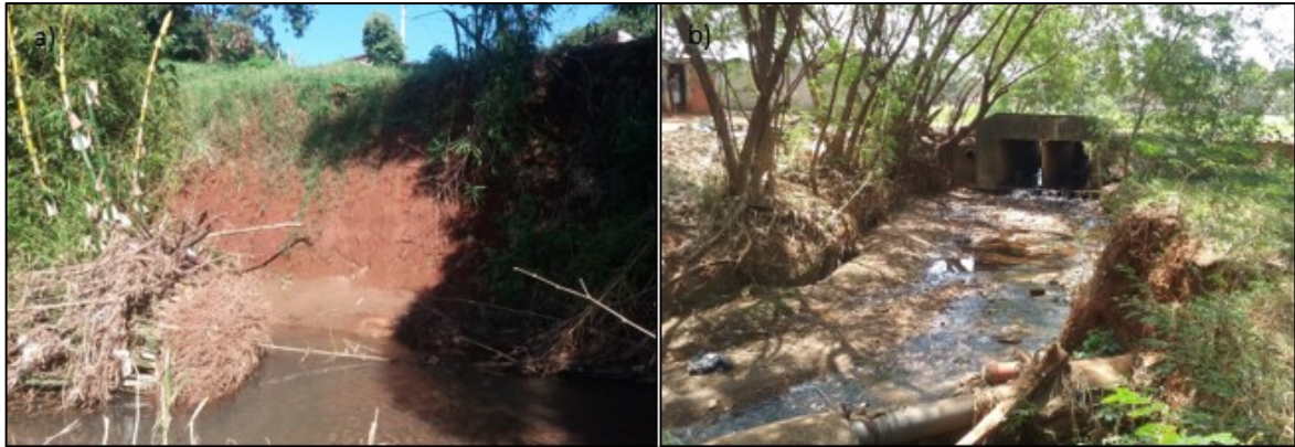
Figura 21 - cena a) quebra de ribanceira zona urbana, cena b) córrego com margens degradada.
