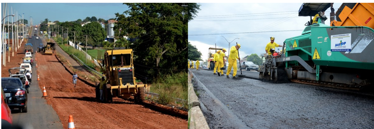
Figura 13 – Obras na GO-060 nos Municípios de Goiânia (a), (b), (c), (d) e Trindade (e), (f) – Ano 2016
