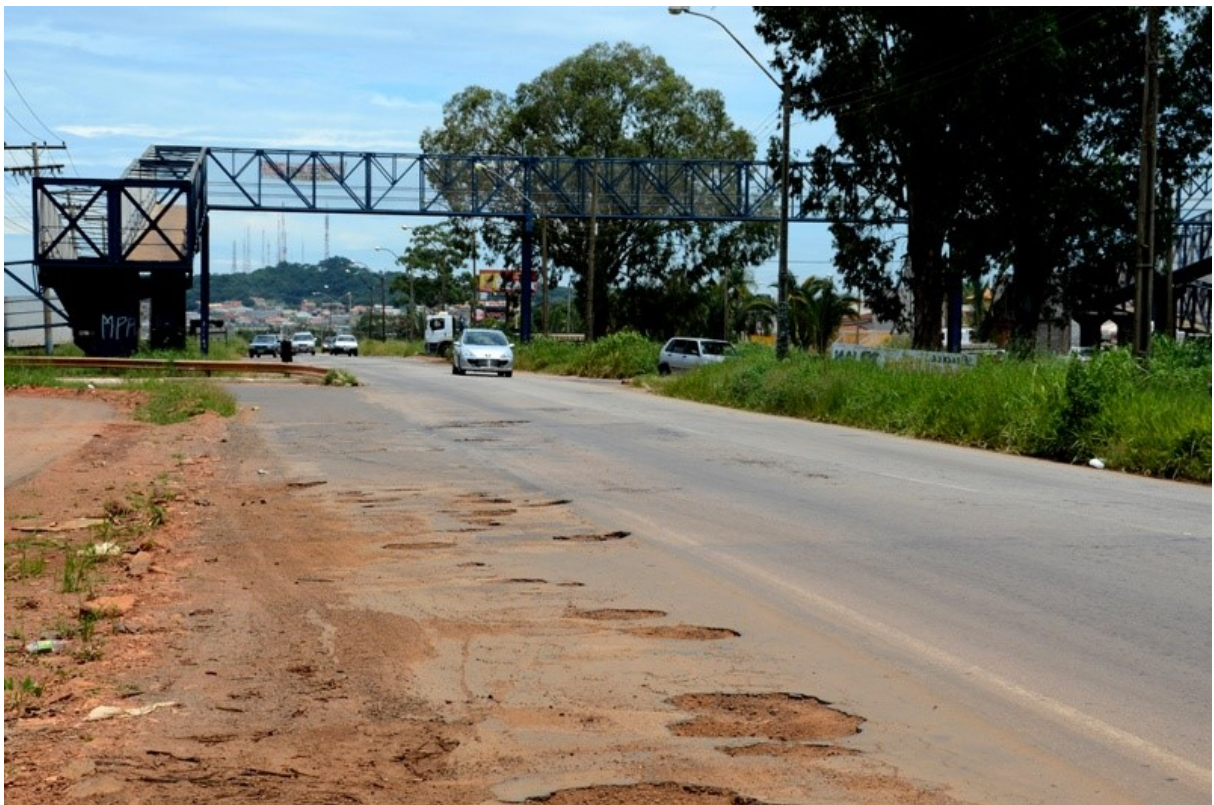
Figura 15 – Rodovia Estadual GO-060 no Município de Goiânia – Trecho: Goiânia – Trindade – Ano 2012
