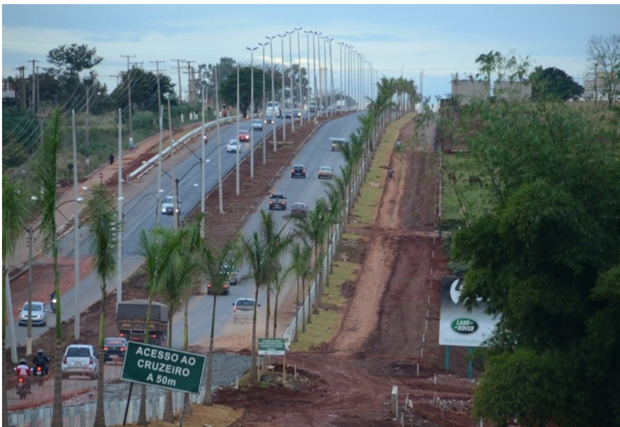
Figura 17 – Rodovia Estadual GO-060 no Município de Trindade – Trecho: Goiânia – Trindade – Ano 2014
