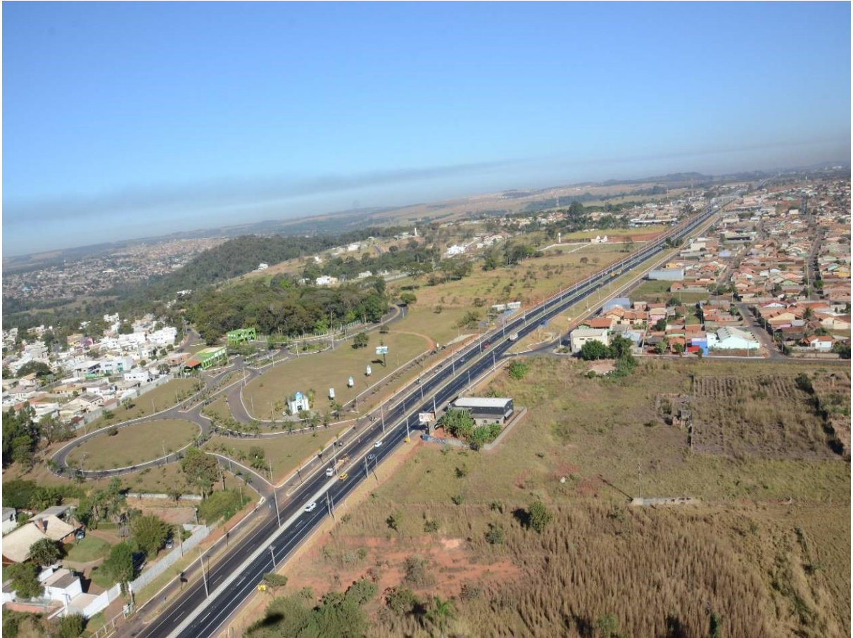
Figura 24 – Rodovia GO-060 em Área de Transição Rural/Urbana no Município de Trindade – Ano 2014
