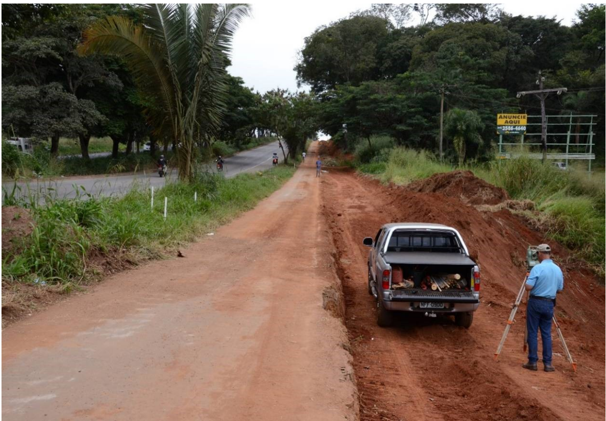
Figura 11 – Início das Obras de Duplicação da Rodovia Estadual GO-060 no Município de Goiânia – Ano 2016
