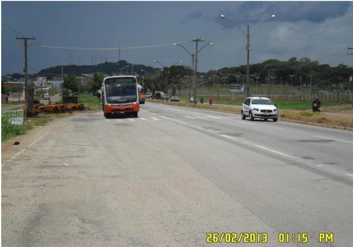
Figura 16 – Rodovia Estadual GO-060 no Município de Goiânia – Trecho: Goiânia – Trindade – Ano 2013
