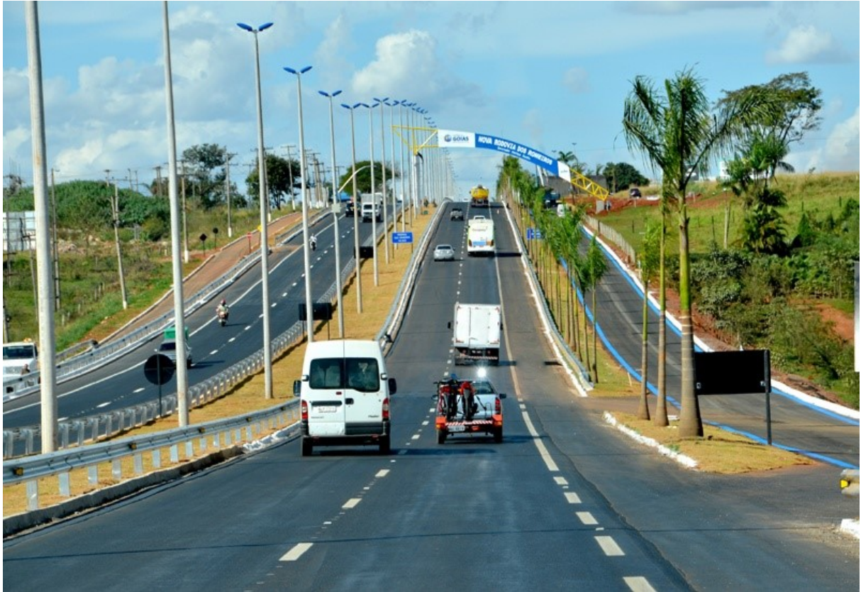
Figura 18 – Rodovia Estadual GO-060 no Município de Trindade – Trecho: Goiânia – Trindade - Ano 2015
