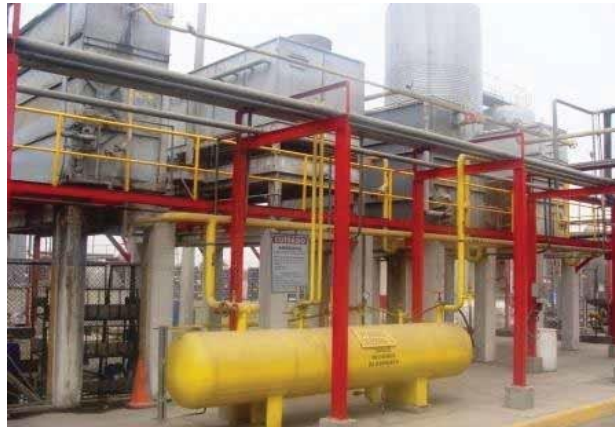
Figura 8 - Reservatório de amônia a alta pressão líquida
