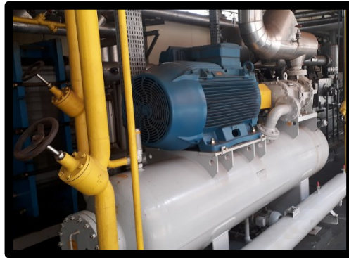
Figura 10 - Compressor Parafuso
