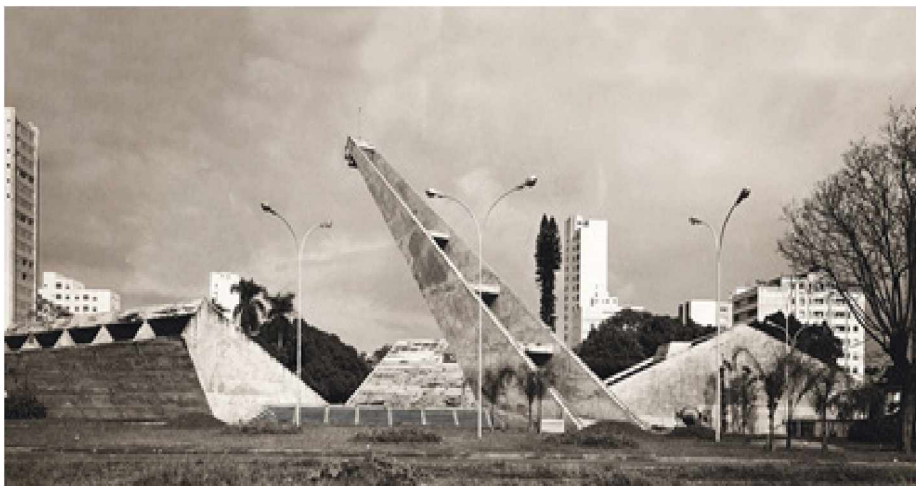
FIGURA 17: imagem do Centro de Convivência Cultural de Campinas com destaque ao concreto aparente.. FONTE: ÁVILA, 1998
