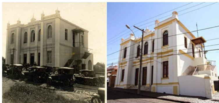
FIGURA 41: imagem da Antiga Cadeia e Fórum em 1935, e atual Casa da Cultura após restauração, 2017.
