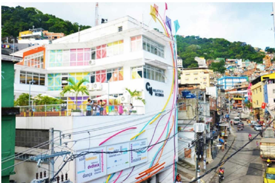
FIGURA 06. imagem externa da Biblioteca Parque da Rocinha FONTE: google imagens - acesso em maio de 2017
