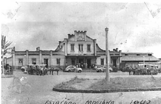
FIGURA 37. imagem da Estação Mogiana na década de 1940. FONTE: PEIXOTO, 2013
