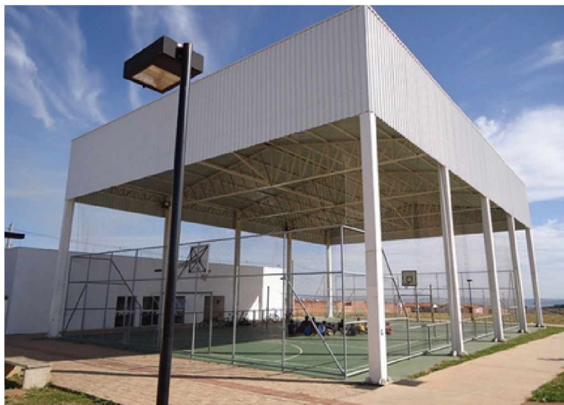
FIGURA 43. Vista da quadra poliesportiva do CEU Monte Moriá, 2017 - arq. desconhecido FONTE: FAEC - acesso em abril de 2017
