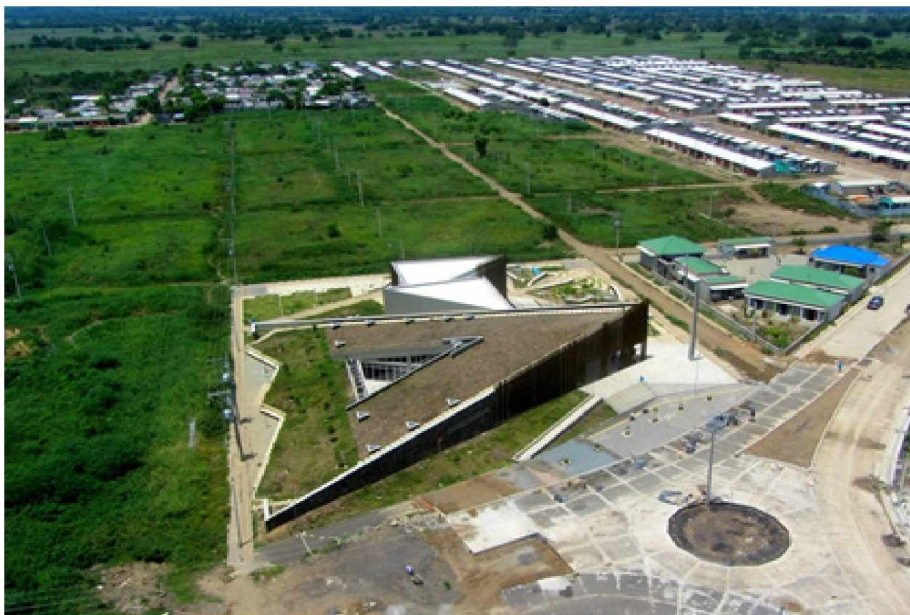
FIGURA 25: vista aérea da localização do Parque Biblioteca David Sanchez Julião. FONTE: http://www.archdaily.com.br/br/756362/biblioparque-david-sanchez-juliao-plus-a662-arquitectos - acesso em abril de 2017
