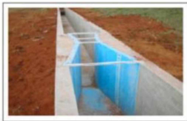
Figura 2 – Misturador hidráulico: Calha Parshall
