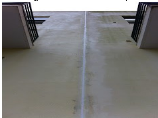
Figura 13 – Junta de dilatação
