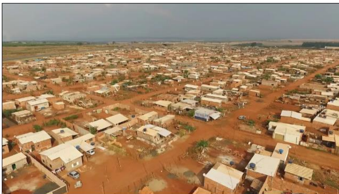
Figura 3 – Unidades habitacionais do Bairro Élisson Prieto
