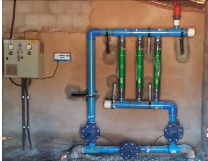
**Figura 1-** Eletromagnetizador instalado no sistema de irrigação localizada
